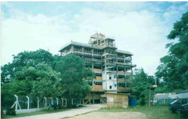
FIG. 23 – Vista do entorno FONTE: Particular
