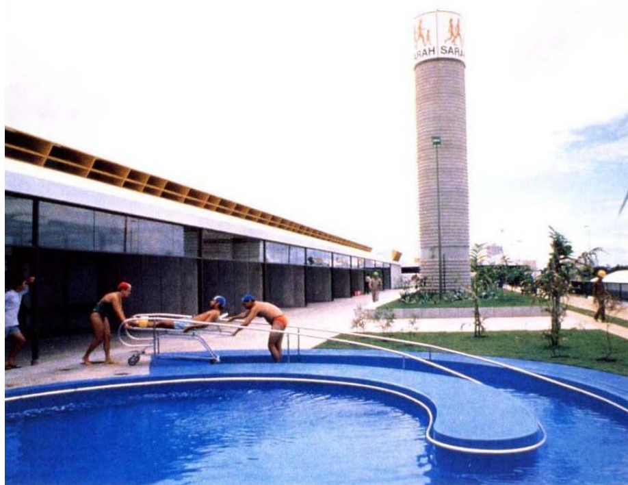
FIG. 6 – Piscina para hidroterapia cuja rampa permite descida de cadeira de rodas e camas-maca - Hospital Sarah Kubitschek/Salvador.
