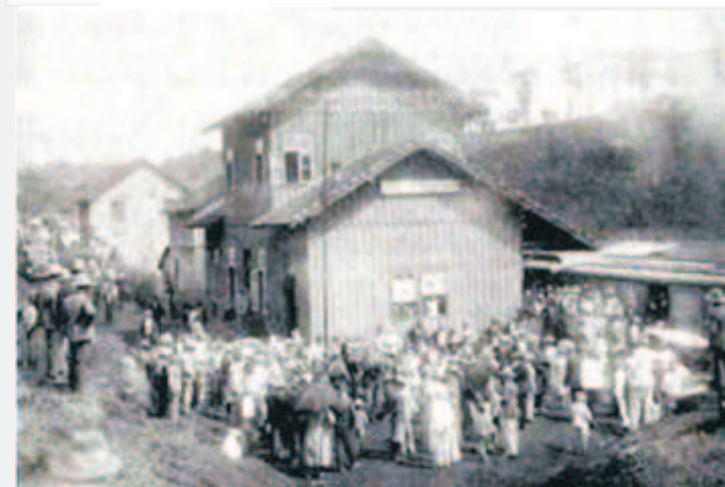
Fotos de 1910 (Inauguração da Estação Rio Caçador)
