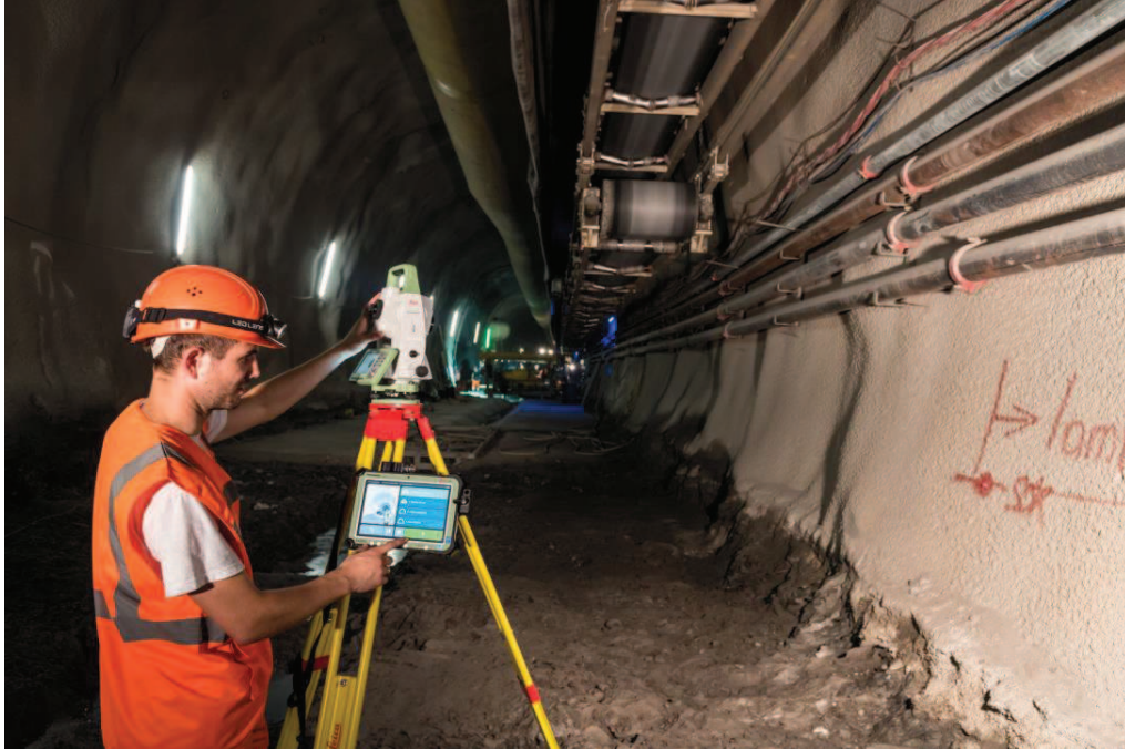
Figura 22 – Levantamento da seção transversal escavada.
