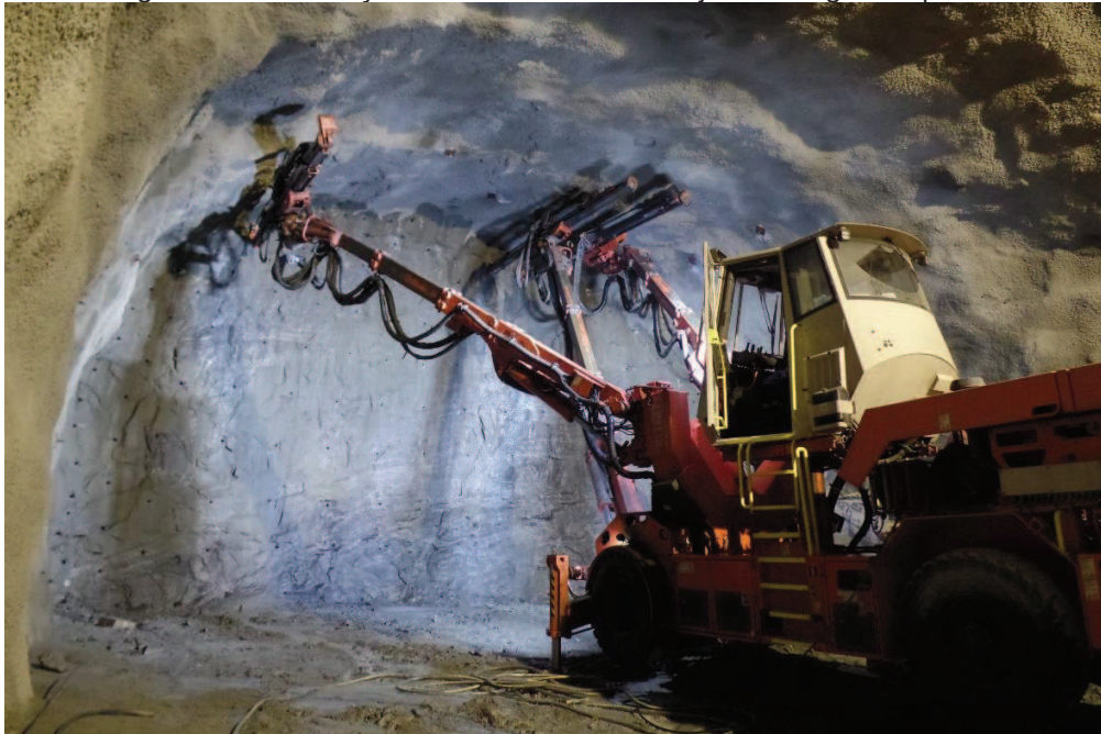
Figura 18 – Perfuração sendo executada com jumbo de grande porte.
