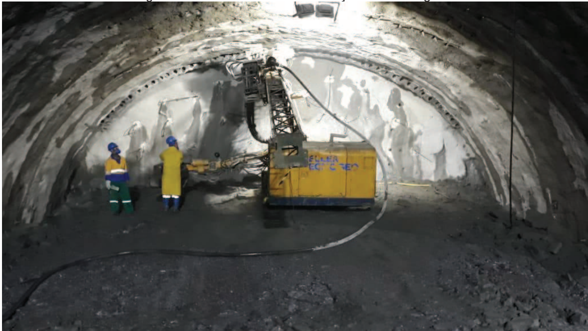
Figura 17 – Vista frontal da meia seção com enfilagens.
