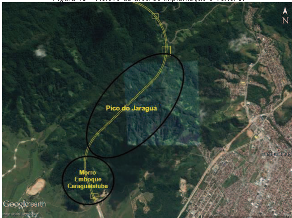
Figura 13 – Relevo da área de implantação o Túnel 5.
