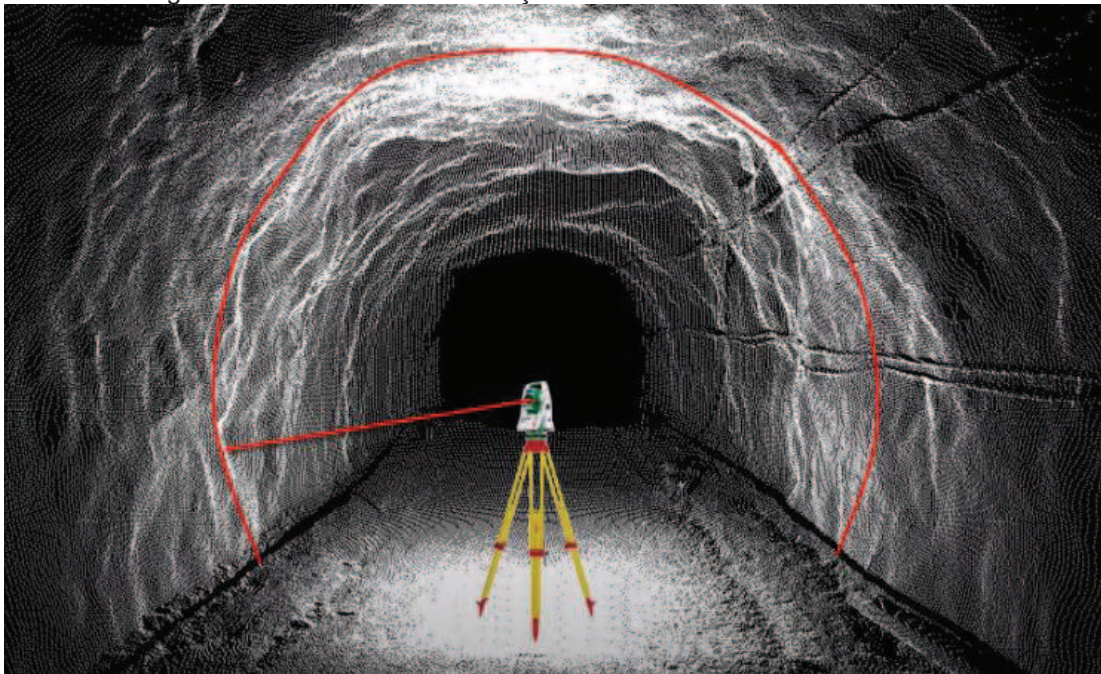
Figura 11 – Levantamento da seção transversal com varredura a laser .
