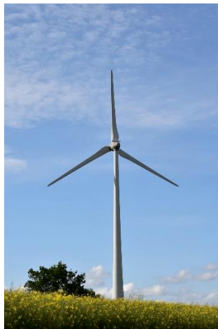
Figura 4.5 – Aerogerador do tipo HAWT com rotor de três pás.
