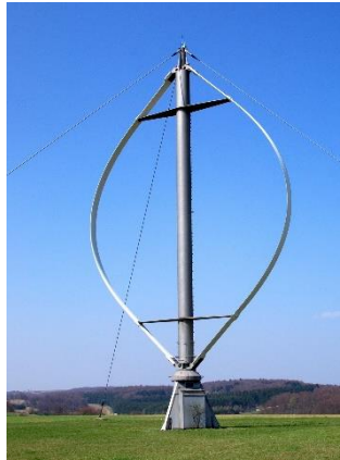
Figura 4.3 – Aerogerador do tipo VAWT com rotor Darrieus.
