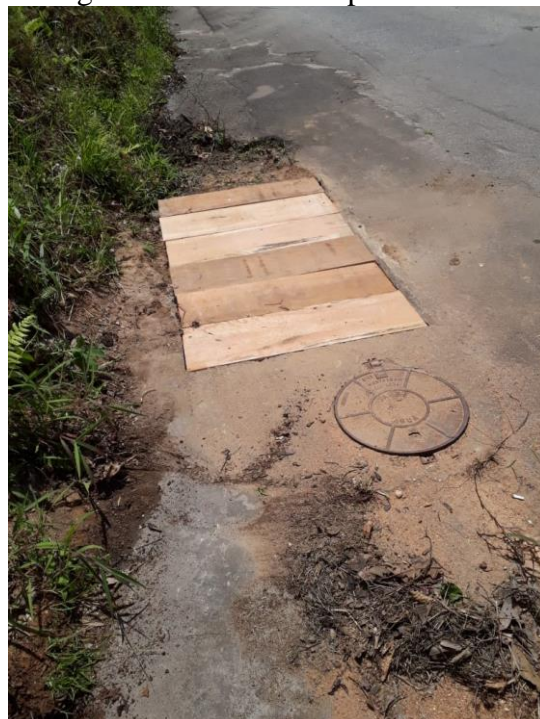
Figura 101 – Nova tampa instalada.
