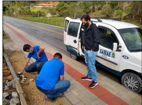
Figura 41 – Instalação datalogger no ponto 2.
