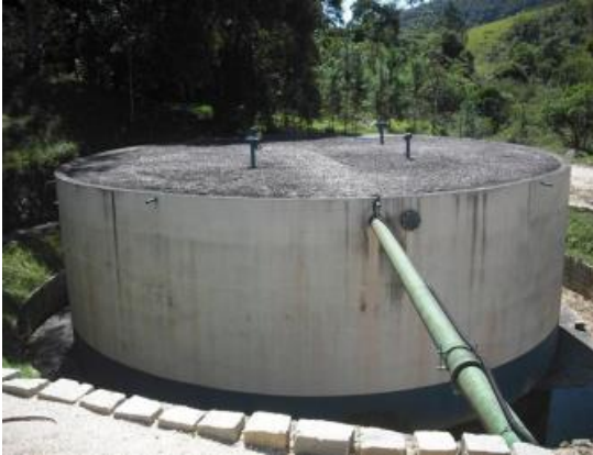
Figura 64 – Reservatório existente, 500 m 3 .
