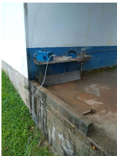
Figura 125 – Aferição de hidrômetro em andamento.
