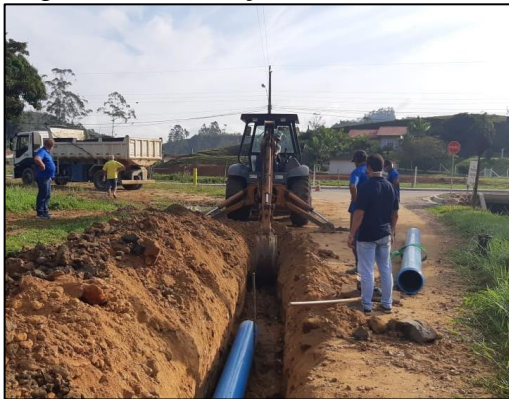
Figura 47 - Execução da troca de rede.
