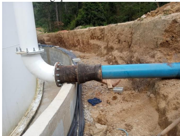
Figura 94 – Interligação do novo reservatório, 05/11/2020.
