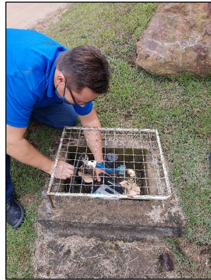
Figura 43 – Instalação de datalogger , ponto 4.
