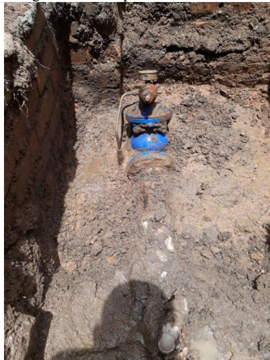
Figura 99 – Limpeza sendo realizada.
