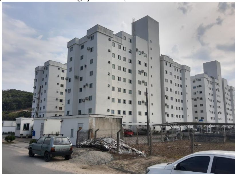
Figura 114 – Local da ligação 32235, Condomínio Residencial 4 torres.
