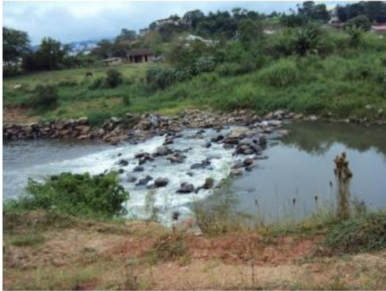
Figura 20 – Captação de água bruta.
