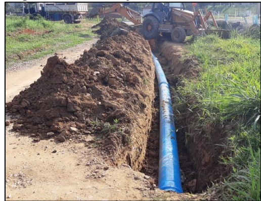
Figura 48 - Execução da troca de rede.
