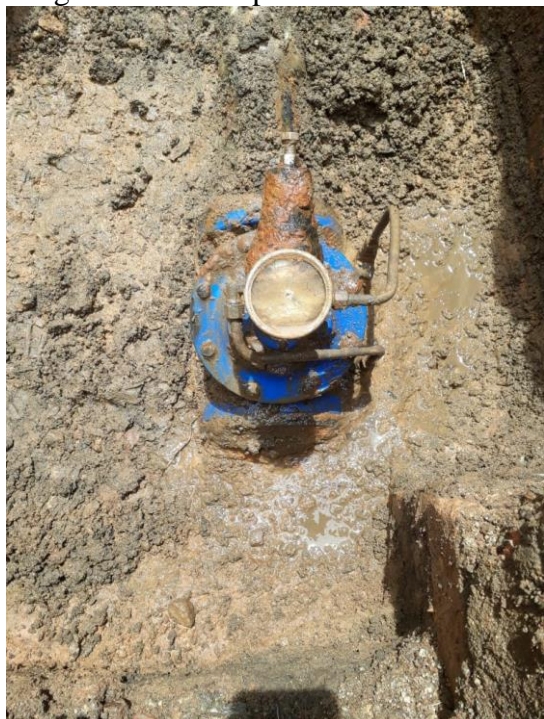
Figura 100 – Limpeza sendo realizada.
