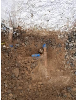
Figura 68 – By-pass identificado.
