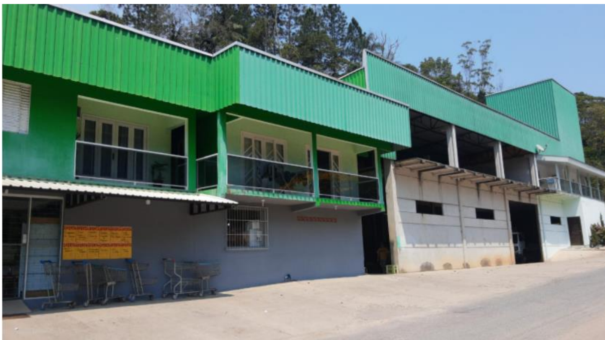
Figura 124 - 1 Residência, 1 supermercado e um galpão no mesmo hidrômetro.
