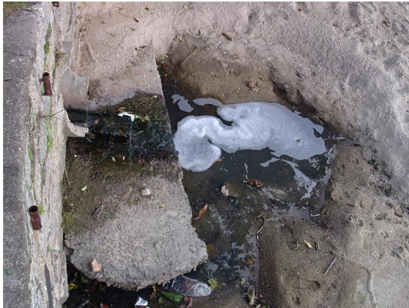
Figura 19 - Tubulação que desemboca próximo ao Ponto 12
