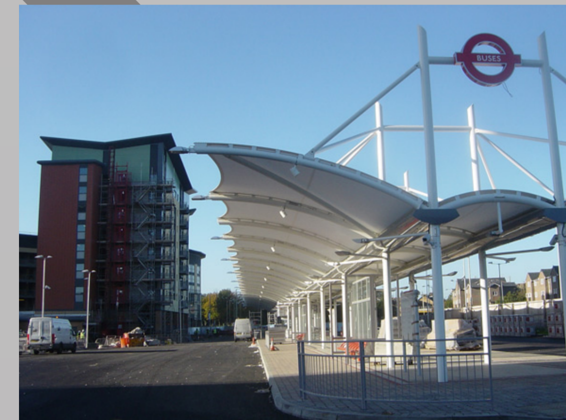
Exemplo de cobertura em um terminal.
