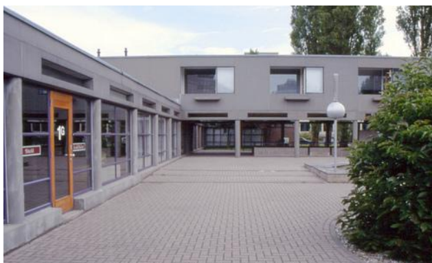
Vista da Entrada.
