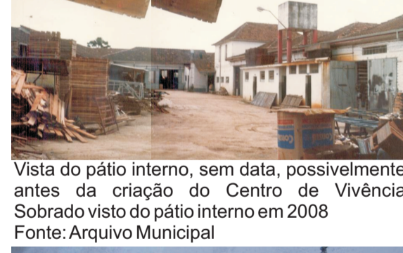
Vista do pátio interno, sem data, possivelmente antes da criação do Centro de Vivência Sobrado visto do pátio interno em 2008 Fonte: Arquivo Municipal
