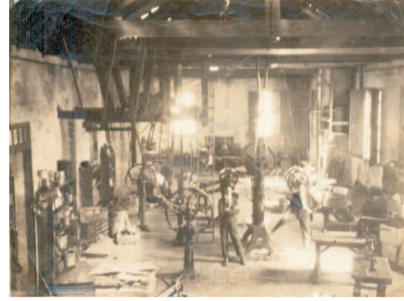
Sala de máquinas 1928 Fonte: Arquivo Municipal
