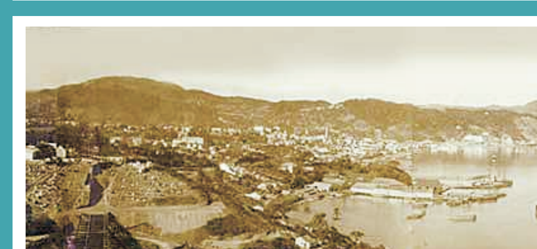
1925. Vendo-se em primeiro plano a Ponte Hercílio Luz em construção. Em segundo plano, o Cemitério Municipal. A esquerda, a chamada do torre do boi. À direita, no meio da baía, a Ilha do Caribó, dependência com o aterro da baía até em 1932, servindo como apoio à construção da Ponte Colombo Salles. Mais à esquerda, a Fábrica de Pregos e de Gelo da Firma Hoepcke, com seu trapiche balneário. Fonte: INGSC
