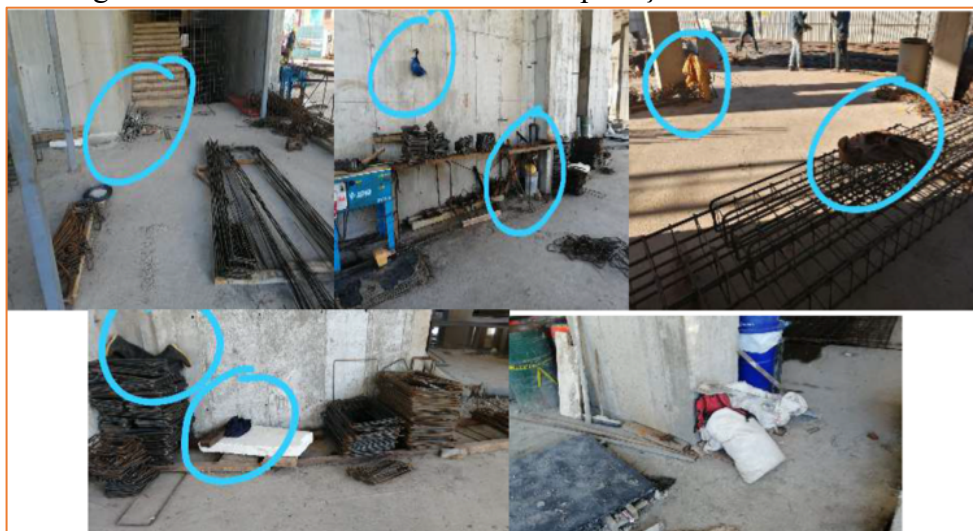
Figura 54 – Local de trabalho antes da aplicação da ferramenta 5S.
