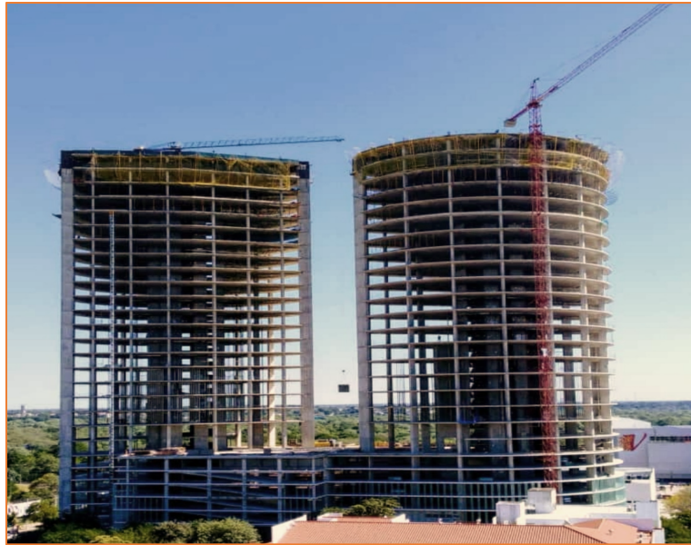
Figura 27 – Superestrutura Manzana 40 em execução.
