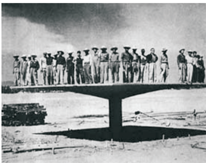
O arquiteto hispano-mexicano Felix Candela conseguiu chegar a economia aproximadamente metade de estrutura convencional de concreto com grandes cascas de argamassa armada, conseguindo suportar vãos de até 15m com espessuras de apenas 4cm.
