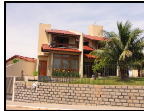
Edificações mais recentes. Fonte: acervo pessoal
