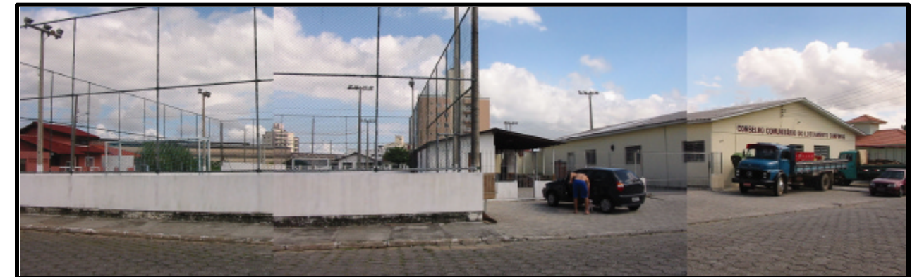
Visão geral do Centro Comunitário de Campinas. A estrutura é simples, mas as pessoas da comunidade, principalmente jovens e idosos, utilizam muito o espaço, confirmando que equipamentos comunitários são muito importantes nos bairros periféricos da cidade. Fonte: acervo pessoal
