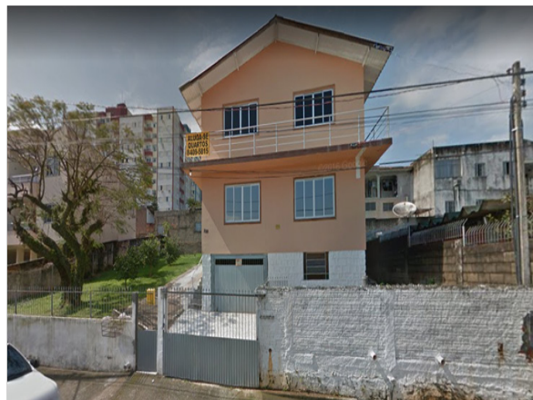
Figura 35- Fachada frontal. Fonte: google maps
