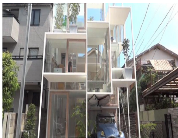
Figura 36– Fachada com transparência. Fonte: site projeto do Japão
