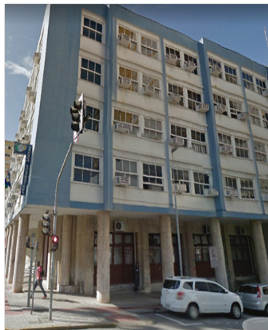
Figura 2- Previdência Social em Florianópolis- Antes. Fonte: Google maps.
