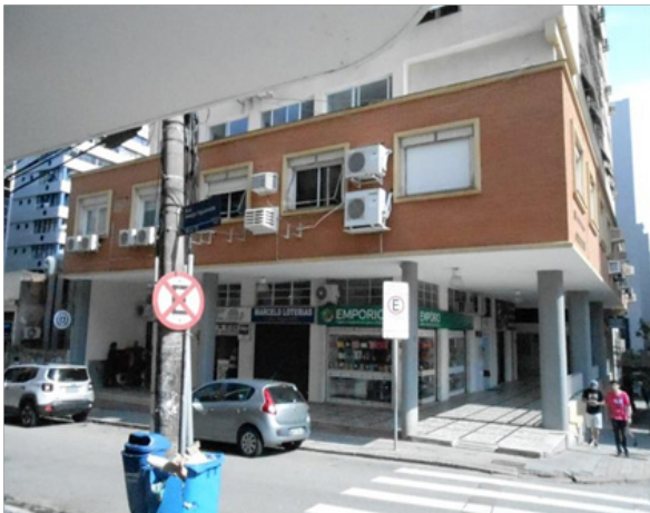
Figura 52- Edificação ao lado do terreno. Fonte: acervo pessoal.
