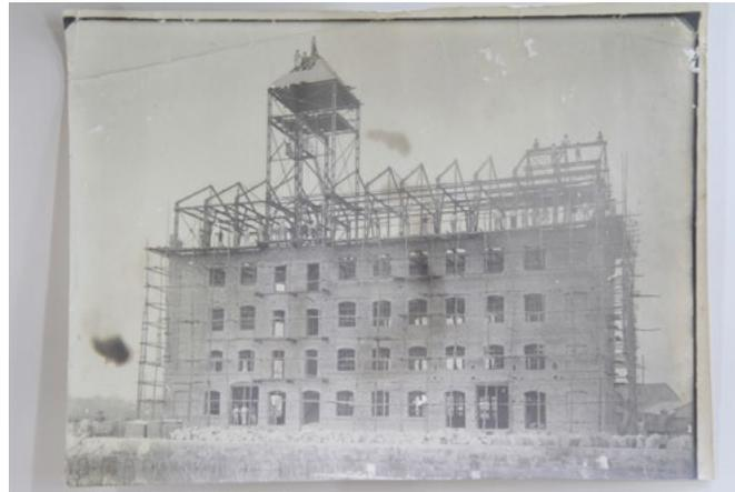
Fase final da construção do Moinho Joinville com fechamento da estrutura através de blocos de alvenaria. Fonte: AHJ
