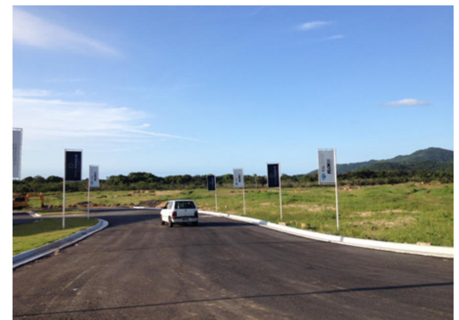
4 - Loteamento já está sendo construídos em vazios urbanos, com a SC-403 Fonte: Autora (Fevereiro, 2016)
