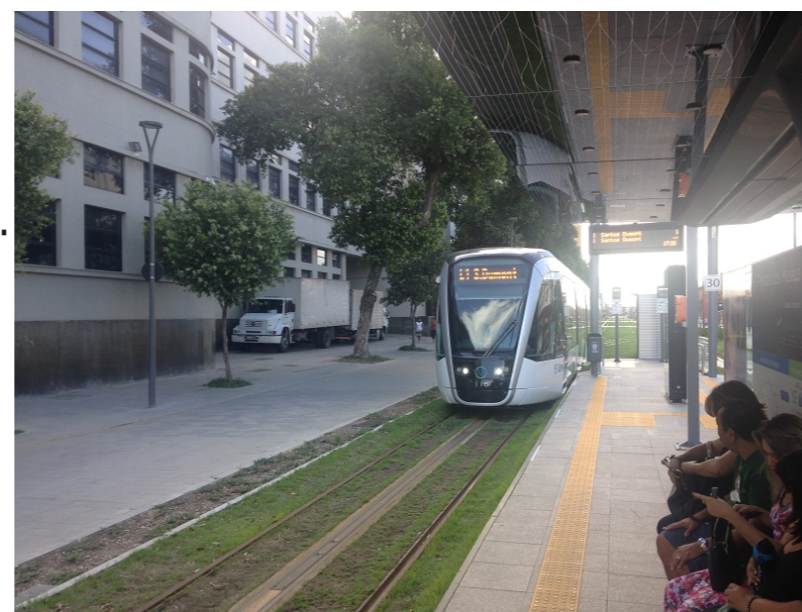
Figura 28. Veículo Leve Sobre Trilhos recém-inaugurado no Rio de Janeiro. Fonte: autora
