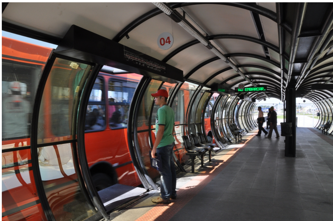
Figura 25. Vista interna de uma Estação Tubo do Sistema BRT de Curitiba. Fonte: PET Engenharia Civil UFPR, 2014
