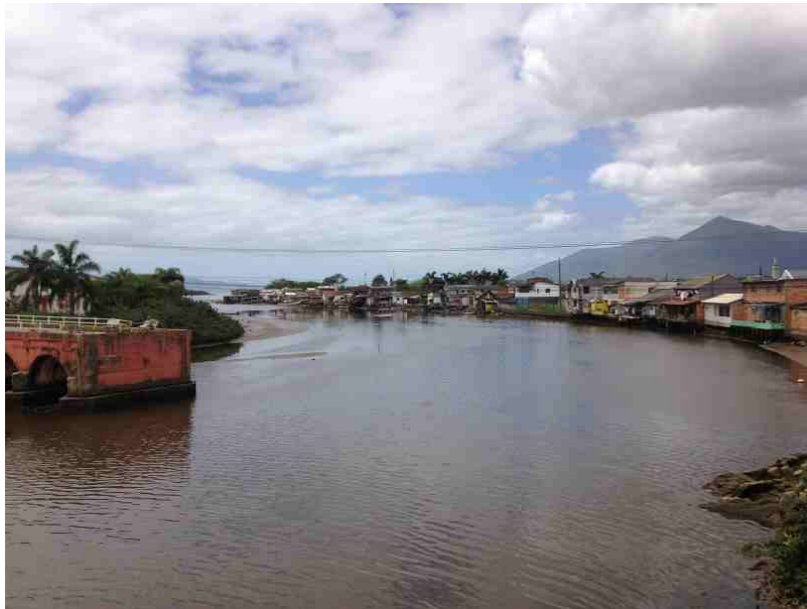
Figura 21. Saída do Rio Maruim para o mar. Localização da parada de barcas. Fonte: Autora
