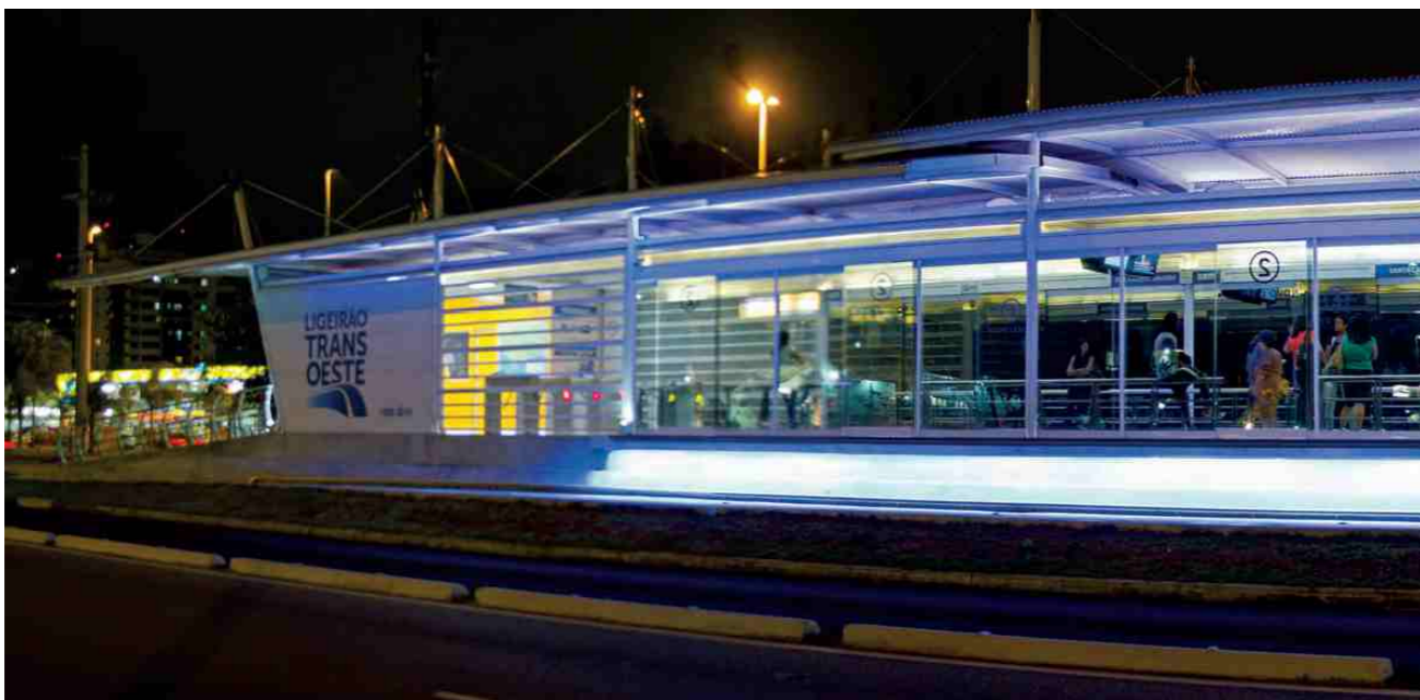
Figura 24. Estação do Sistema BRT do Rio de Janeiro. Fonte: Embarq, 2015
