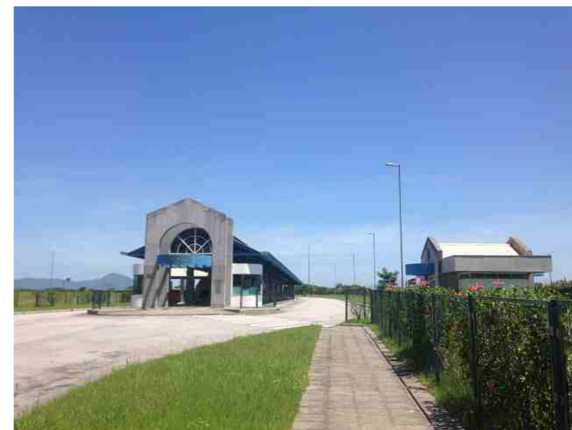
Figura 9. O Terminal inativo do Saco dos Limões. Fonte: autora
