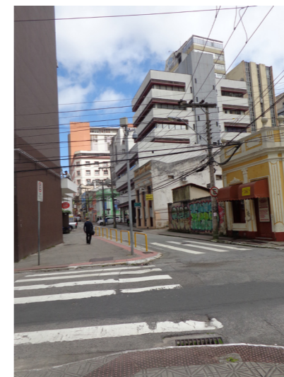
Fig. 56: Total falta de relação entre as construções e o pedestre. Fonte: Acervo pessoal 07-11-15.
