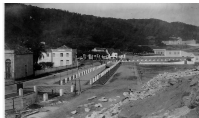
Fig. 163: As obras de canalização do Rio da Bulha. Fonte: PACHECO, Denise. Visões Urbanas da Cidade de Florianópolis. SC, UFSC, 2009.
