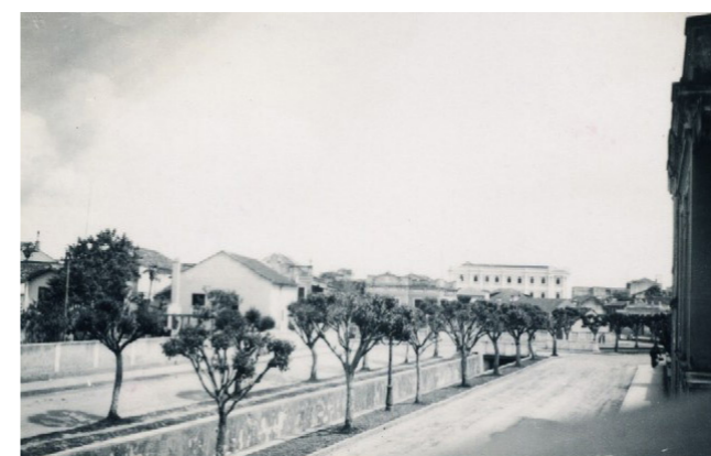
Fig. 158: Canal da Avenida Hercílio Luz, pós intervenção do urbanismo sanitaria. Fonte: http://santacatarinaantiga.blogspot.com.br/2013_05_01_archive.html Acesso em 29/09/2015..
