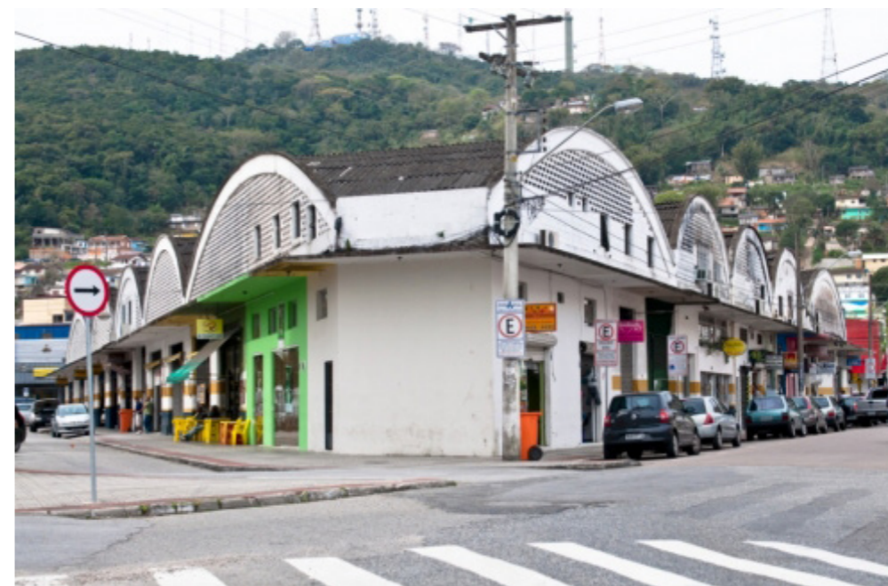
Fig. 92: Antiga Rodoviária Municipal atualmente, encontra-se em um terreno nobre e bastante desvalorizada. Fonte: http://www.skyscrapercity.com/showthread.php?t=1608237&page=161 Acesso em 06-02-16.
