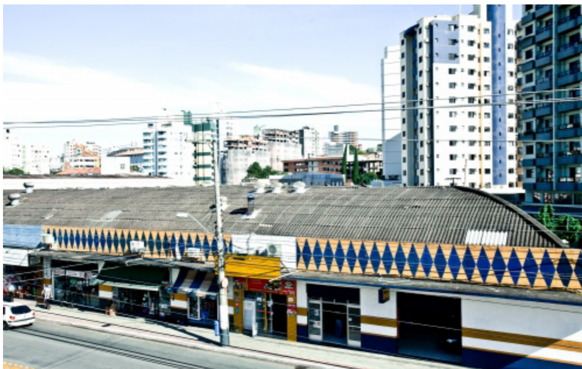
Fig. 91: Antiga Rodoviária Municipal atualmente, com ocupação irregular de comerciantes. Fonte: http://www.skyscrapercity.com/showthread.php?t=1608237&page=161 Acesso em 06-02-16.
