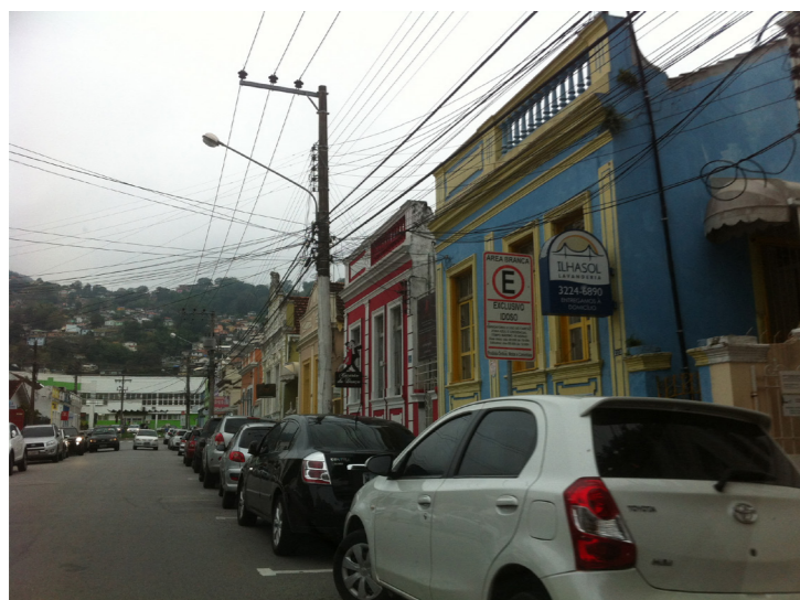
Fig. 224: Conjunto de casarios históricos no trecho da Rua Herman Blumenau entre as Avenidas Hercílio Luz e Mauro Ramos. Fonte: Acervo pessoal 29-06-16.
