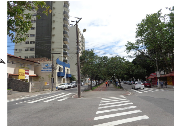
Fig. 37: Calçadas interrompidas por cruzamentos. Fonte: Acervo pessoal 07-11-2015.
