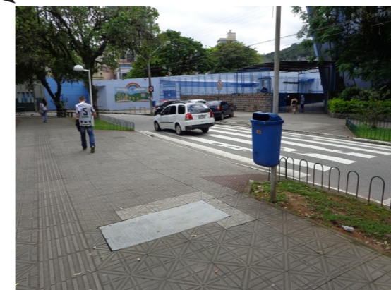
Fig. 71: Ao menos foram feitos os desníveis para passagem com cadeira de rodas, carrinhos de bebê, etc. Fonte: Acervo pessoal 07-11-15.
