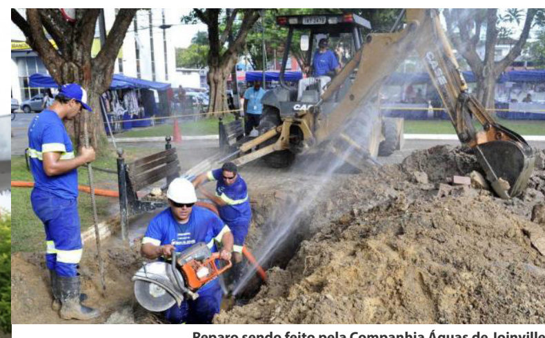
Reparo sendo feito pela Companhia Águas de Joinville. Fonte: anoticia.clicrbs.com.br
