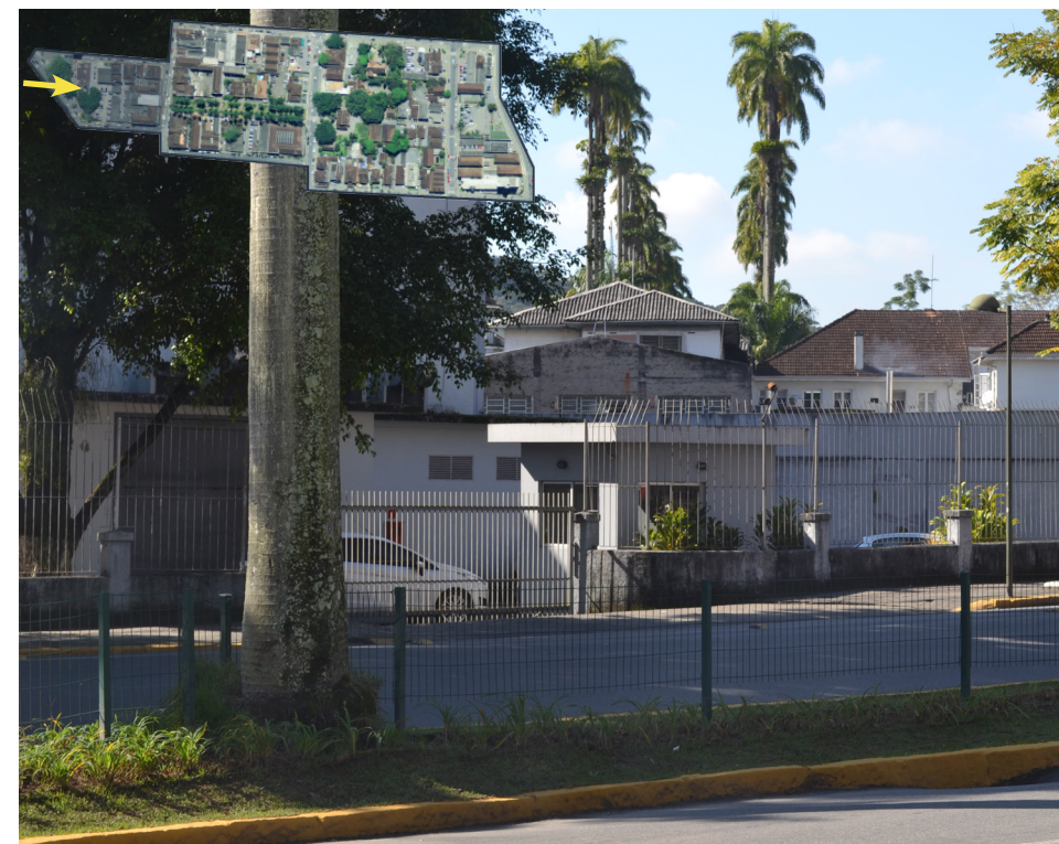
Grades e estacionamentos conformam o limite do recorte com a Avenida JK. Fonte: Autora, 2016.
