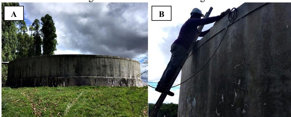
Figura 4 - Abastecimento de água
