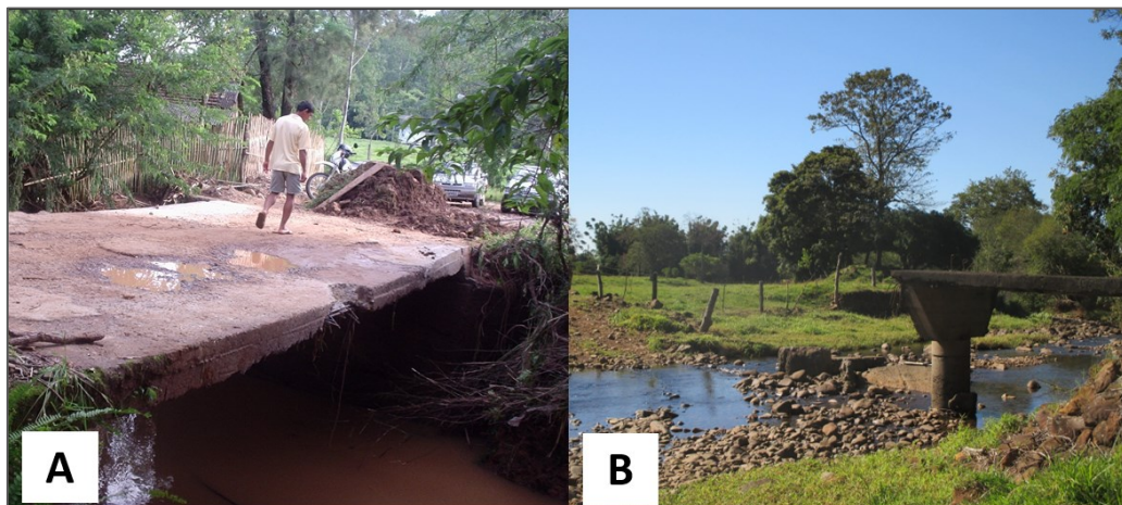
Figura 34 - Pontes danificadas no evento de 2007 (a) no rio Molha Coco e (b) no rio Malacara.
