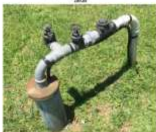
Figura 4.2: Poço tubular profundo localizado na Área Sede
