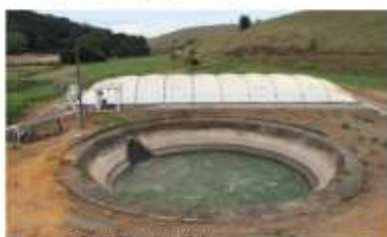
Figura 5.10: Biodigestor tipo canadense e armazenamento do biofertilizante em lagoa de estabilização
