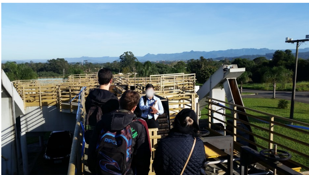
Figura 10. ETE Santa Luzia em Criciúma
