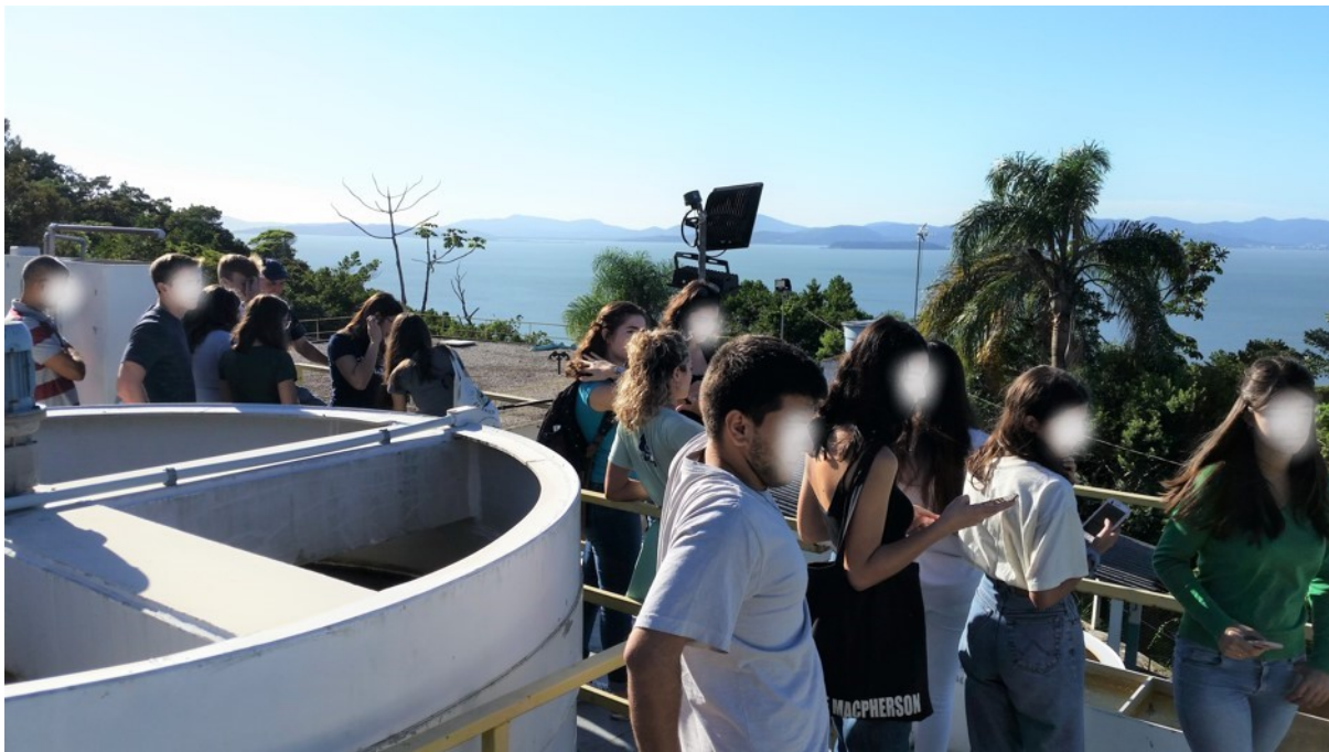
Figura 6. ETA São Miguel em Biguaçu
