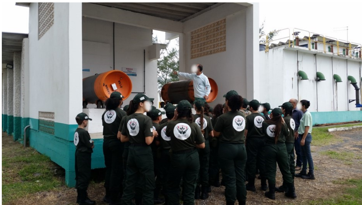
Figura 19. ETA em Laguna
