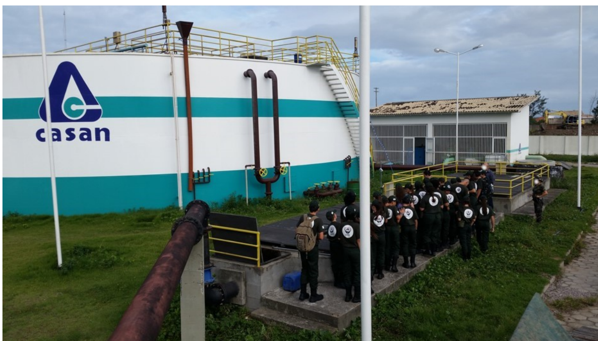
Figura 18. ETE em Laguna
