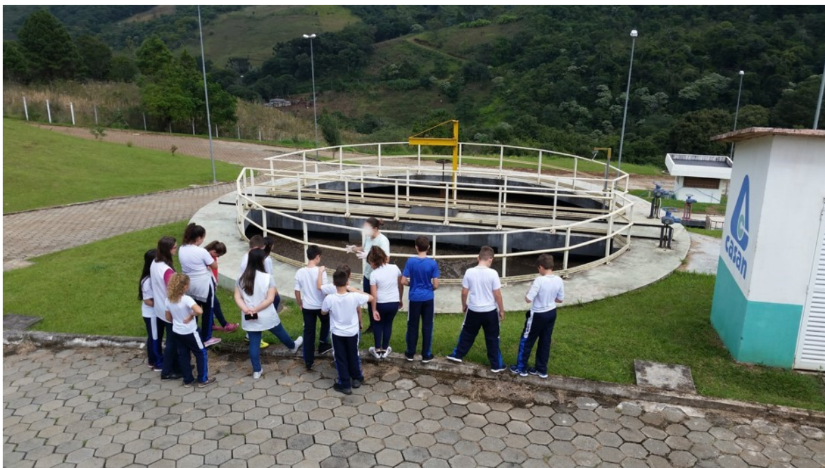
Figura 12. ETE em Dionísio Cerqueira
