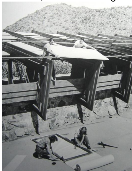
Figura 4 – Aprendizes de Wright montam os painéis de cobertura do ateliê de desenho de Taliesin West, em 1946. Fotografia de Ralph Crane.
