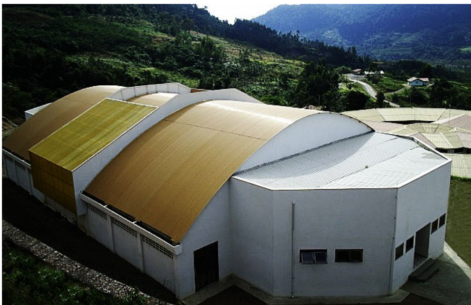
Escola Laklãnõ recém-construída em 2004
