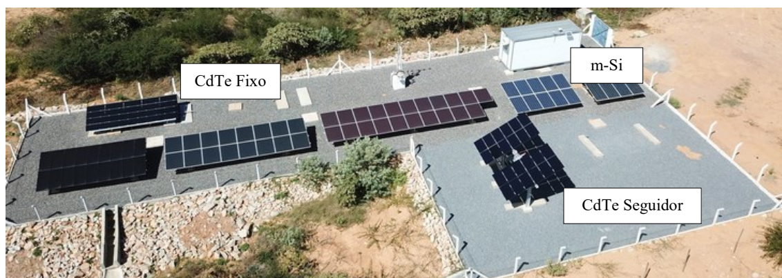
Figura 18 - Vista aérea dos sistemas fotovoltaicos instalados em Brotas de Macaúbas-BA.
