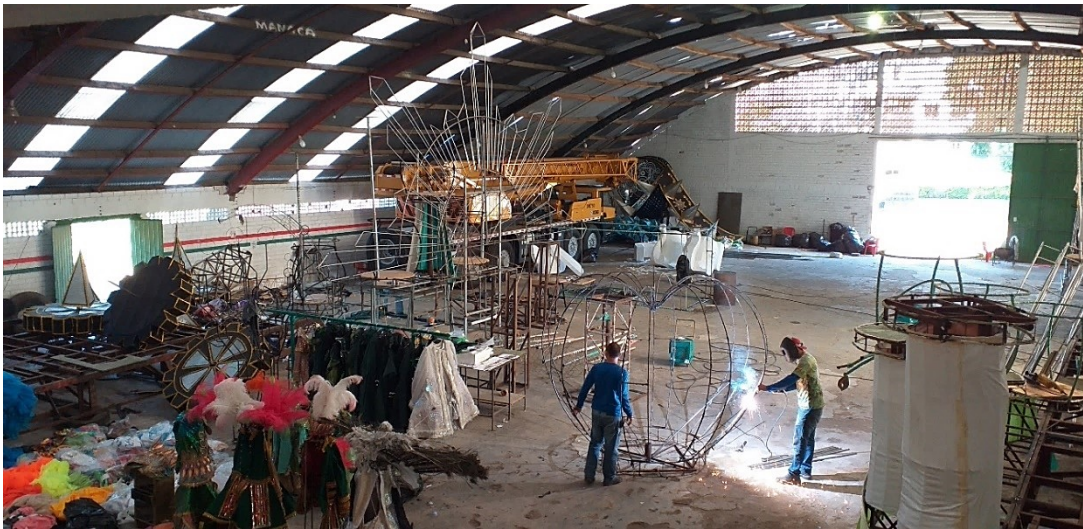
Figura 24 – Kiki e Louro soldando estrutura metálica, ao fundo peça do primeiro carro já finalizada.
