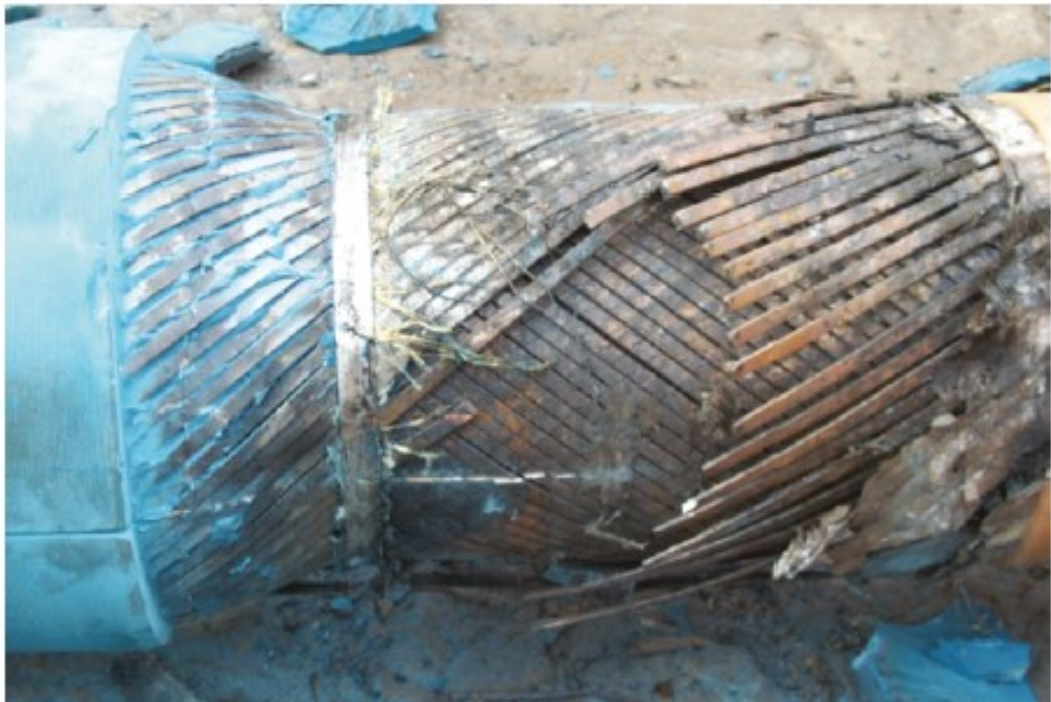
Figure 2.7. Broken tensile armor wires due to tensile fatigue [22].
