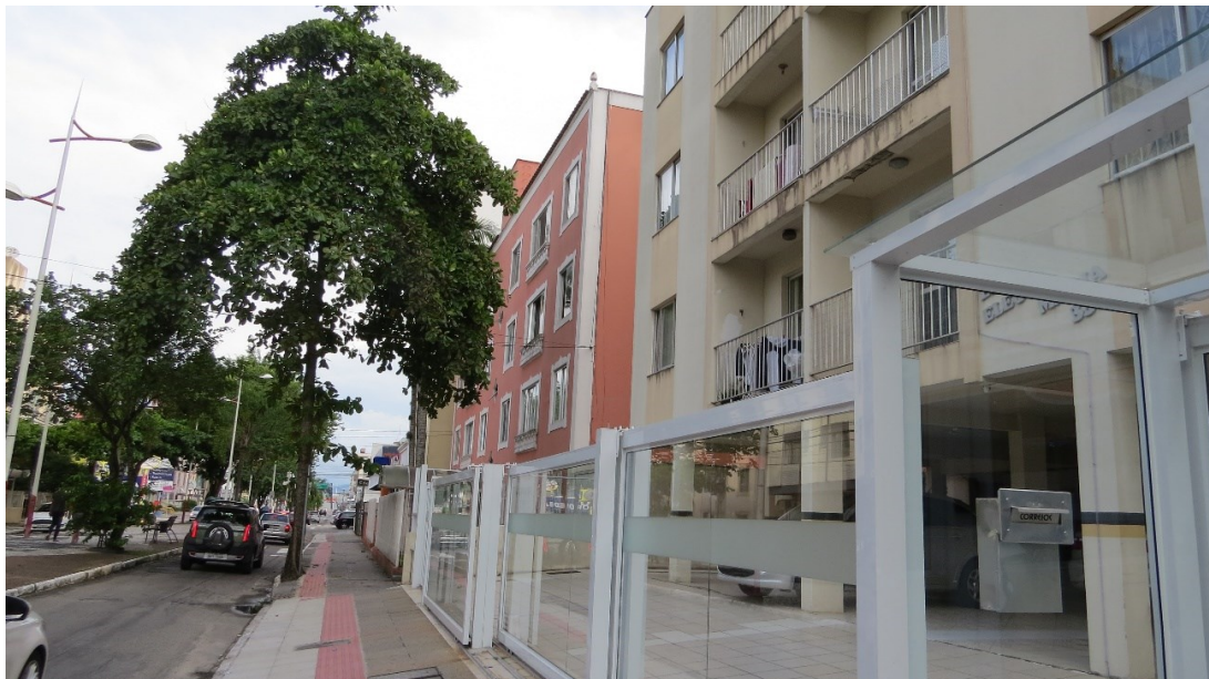
FIGURA 8 – Prédio popular no Kobrasol
