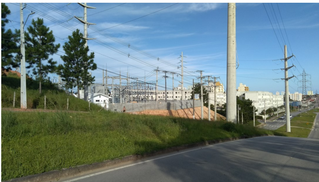
FIGURA 30- Nova Subestação da CELESC na Avenida da Torres em São José/SC
