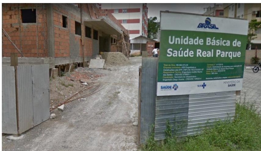
FIGURA 15 – Construção da Unidade Básica de Saúde do bairro Real Parque com recursos federais
