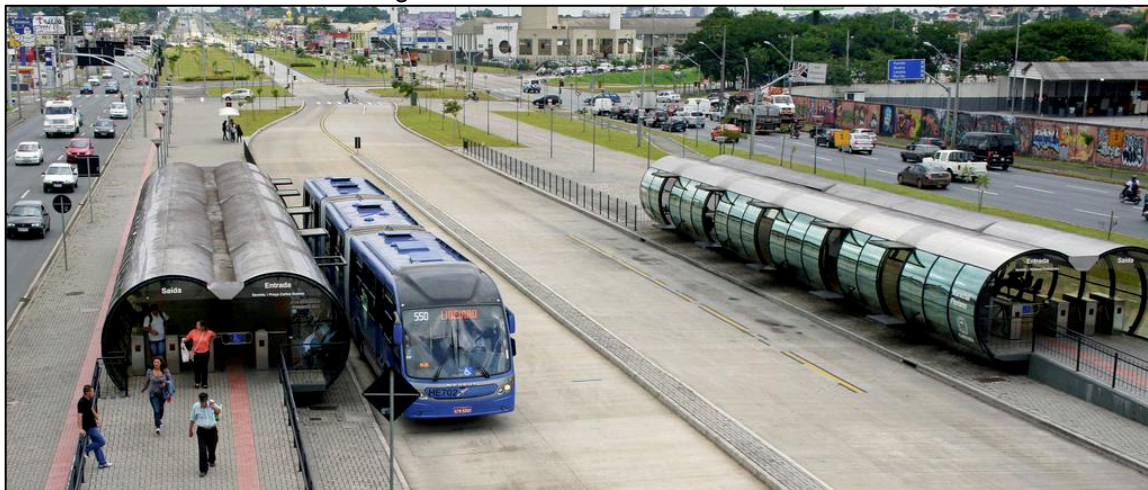
Figura 12 – BRT em Curitiba/PR
