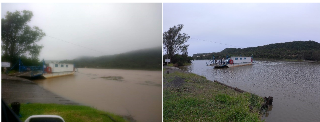
Figura 30 - Diferentes condições verificadas no Ponto Balsa - rio Araranguá, conforme variação da vazão. A: Q > Q_{10} – Fluvial, com forte corrente e alta turbidez durante evento de alta pluviosidade; B: Q < Q_{mlt} – Marinho, com corrente de enchente e baixa turbidez.
