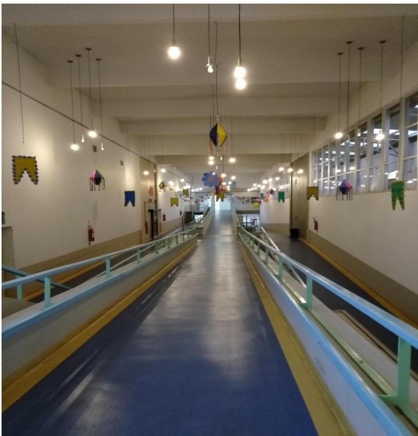
Figura 6. Ambiente fotografado: Corredores e rampas.
