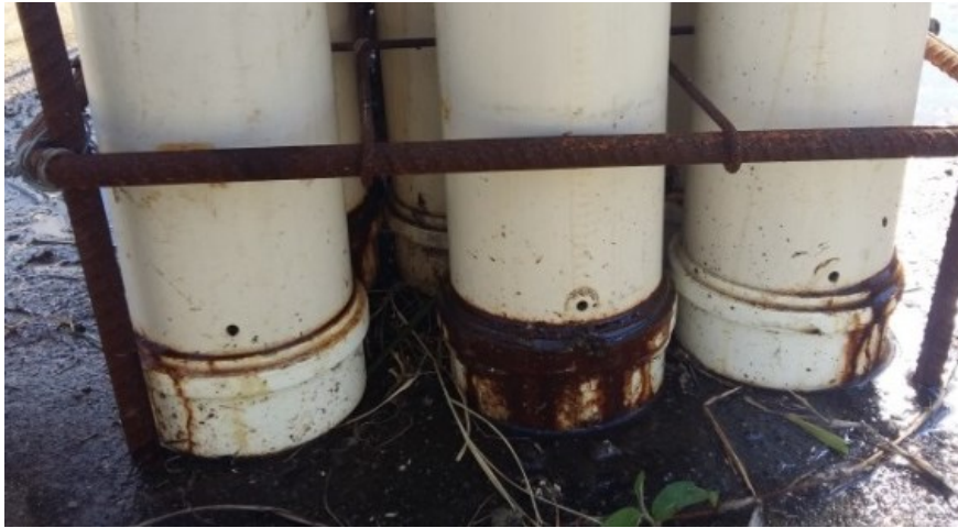
Figura 23 - Demonstração dos furos realizados na parte inferior dos reatores.
