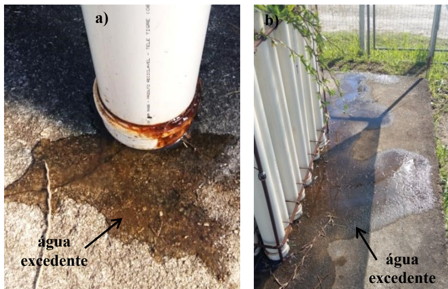
Figura 24 - Umidade excessiva presente nos reatores. a) Água que escoou de um reator ao ser efetuado o furo. b) Total de água que escoou dos reatores, ao serem efetuados os furos.
