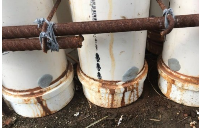
Figura 25 - Recobrimento dos furos com massa plástica (29/05/2018).
