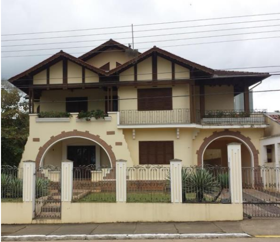
Figura 275 – Atual Pousada Nona Rosina, Ascurra. Residência projetada em 1959
