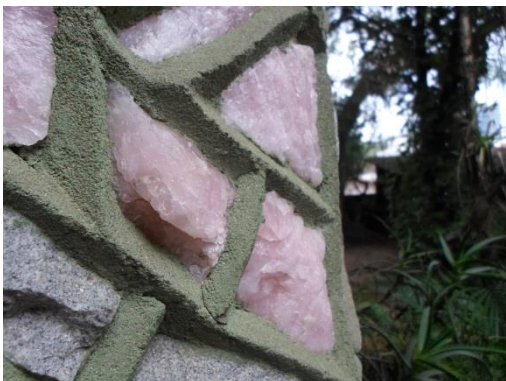
Figura 43 – Vila Quisisana, Brusque (2017). Detalhe do revestimento externo com pedras de quartzo rosa
