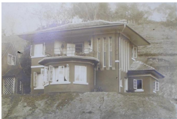
Figura 47 – Residência de Willy Belz projetada por Simão Gramlich em 1933
