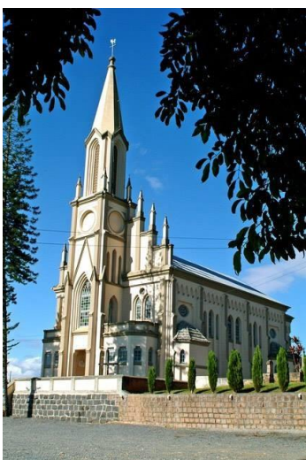
Figura 61 – Capela São Bonifácio, Indaial (SC)
