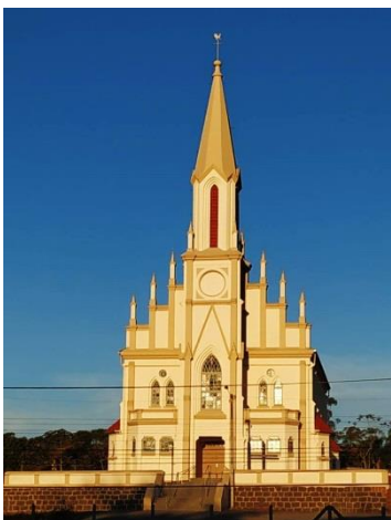
Figura 269 – Capela São Bonifácio, Indaial (Encano). O início da construção deste templo se deu em 1942
