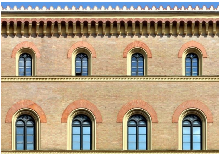
Figura 22 - Mísulas contínuas ( corbel table ) abaixo do beiral e molduras ao redor dos arcos das janelas da Staatsbibliothek (1832-1843) - Munique 100
