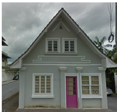
Figura 39 – Antiga residência de Emílio Rosemann
