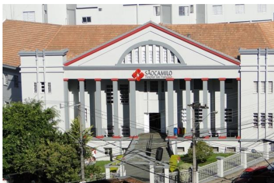
Figura 284 – Hospital São Francisco, Concórdia
