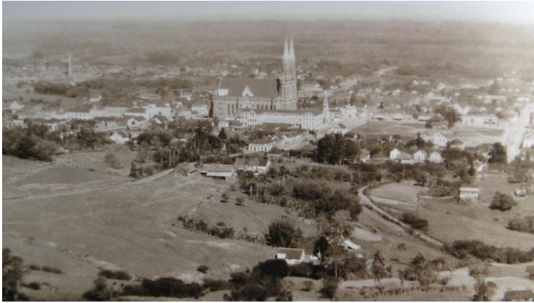
Figura 11 - Vista panorâmica da cidade de Santa Cruz do Sul, cuja Catedral São João Batista, projetada por Simão Gramlich, na década de 1930, encontra-se ao centro da imagem
