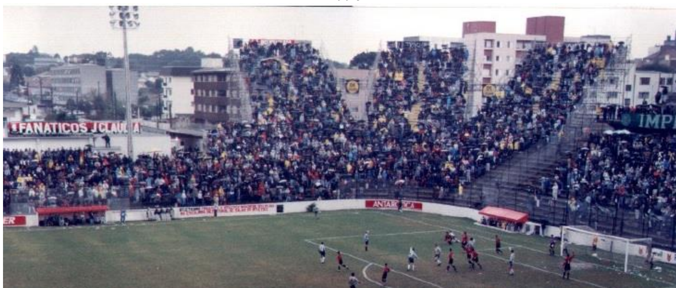
Figura 29 - Estádio Joaquim Américo Guimarães, arquibancadas metálicas adotadas em 1996
