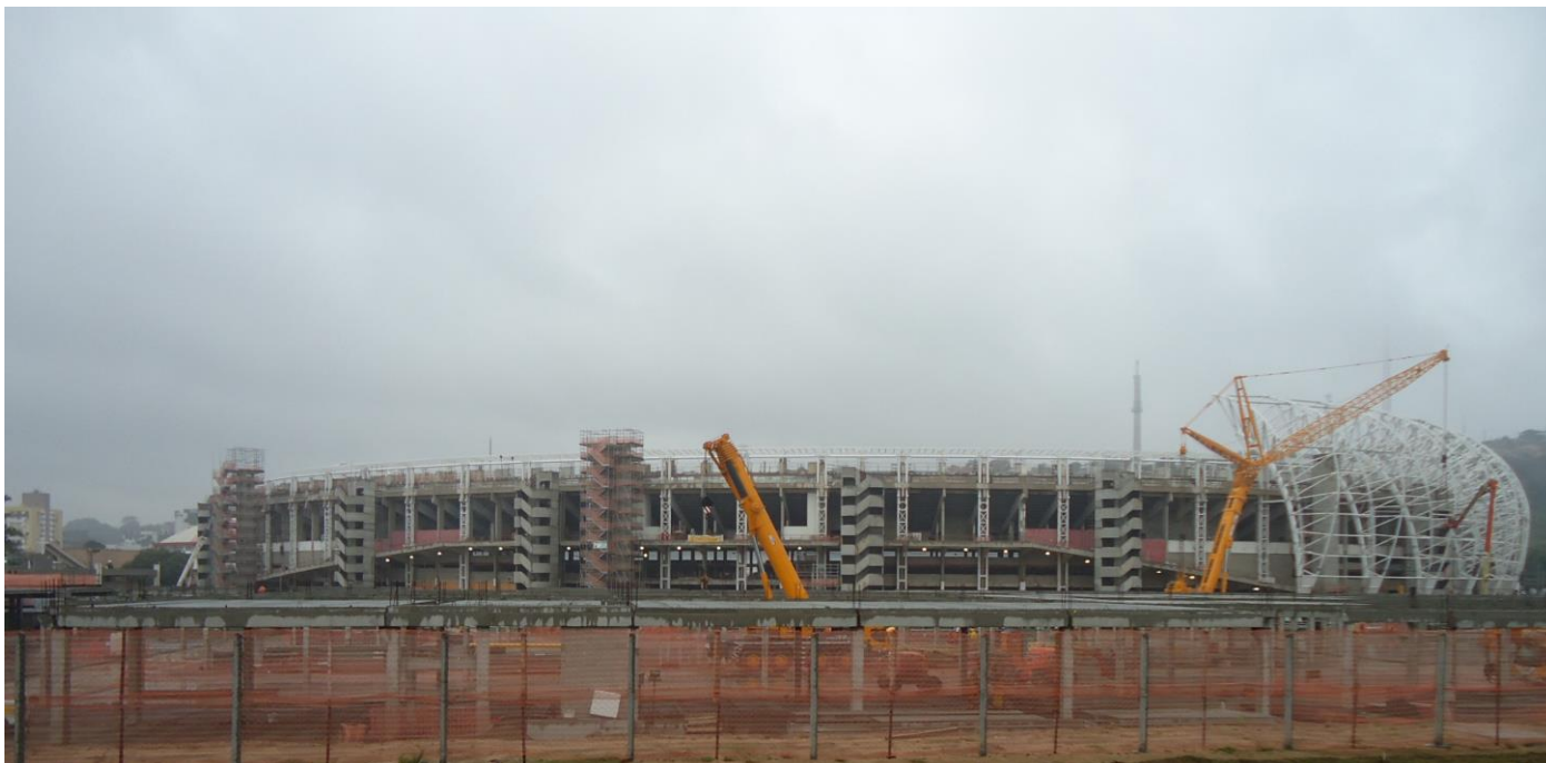
Figura 26 - Obras do Estádio Beira-Rio (2013)
