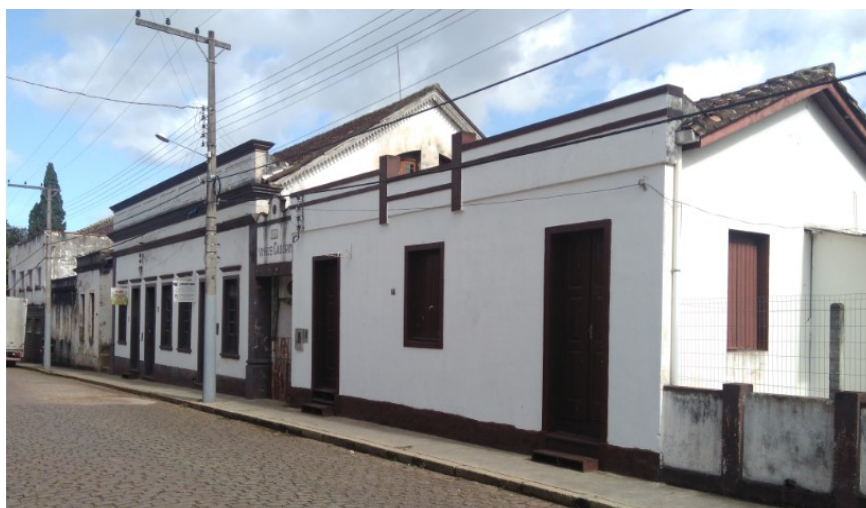
Figura 31 - Edificação da antiga Vinícola Cadorin
