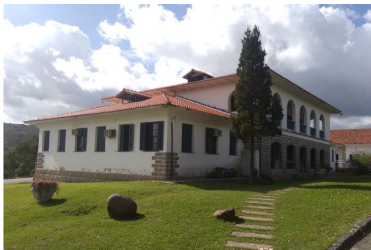
Figura 30 - Unidade da Epagri em Urussanga
