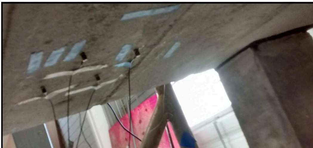
Figura 24: Acelerômetros fixados abaixo da laje da bancada.
