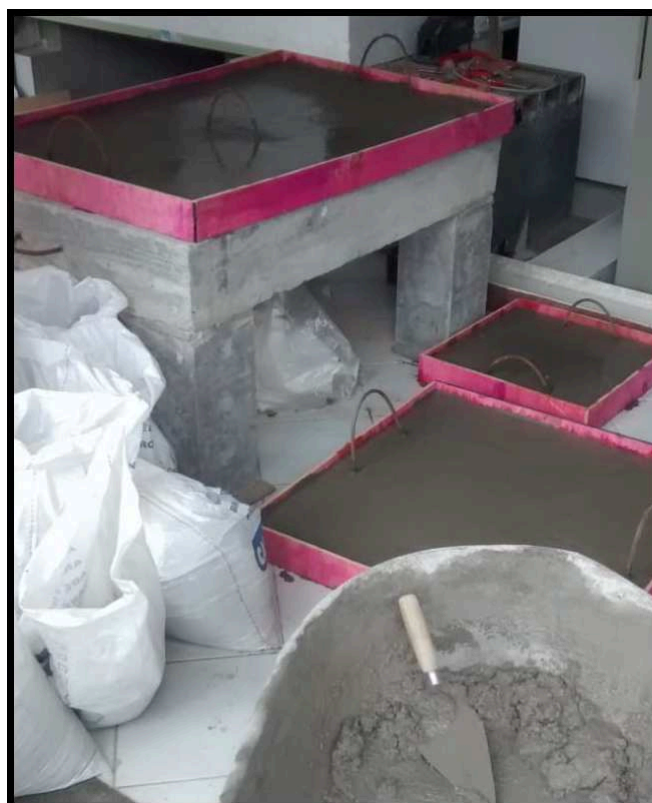
Figura 23: Moldes de contrapisos.
