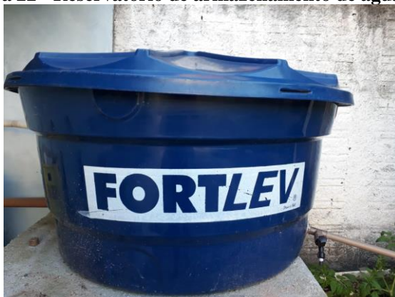
Figura 22 - Reservatório de armazenamento de água cinza
