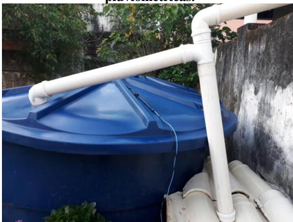
Figura 16 - Dispositivo de descarte das primeiras precipitações pluviométricas.
