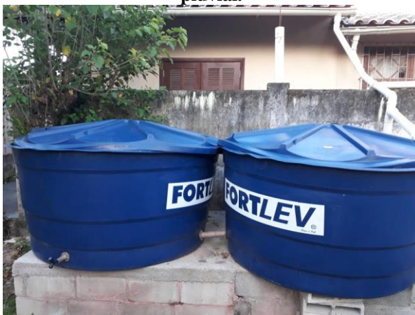
Figura 17 - Reservatórios inferiores de armazenamento de água pluvial.
