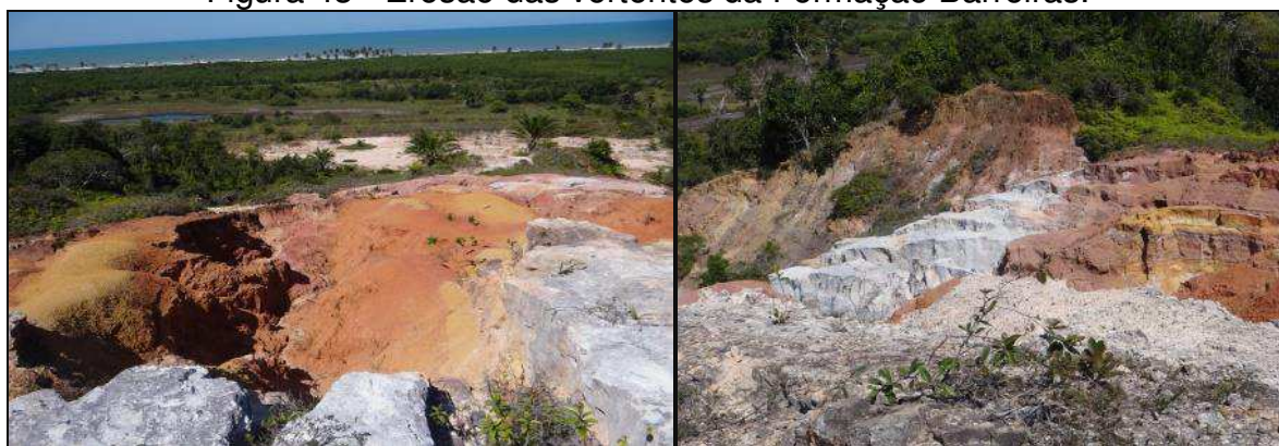
Figura 43 - Erosão das vertentes da Formação Barreiras.
