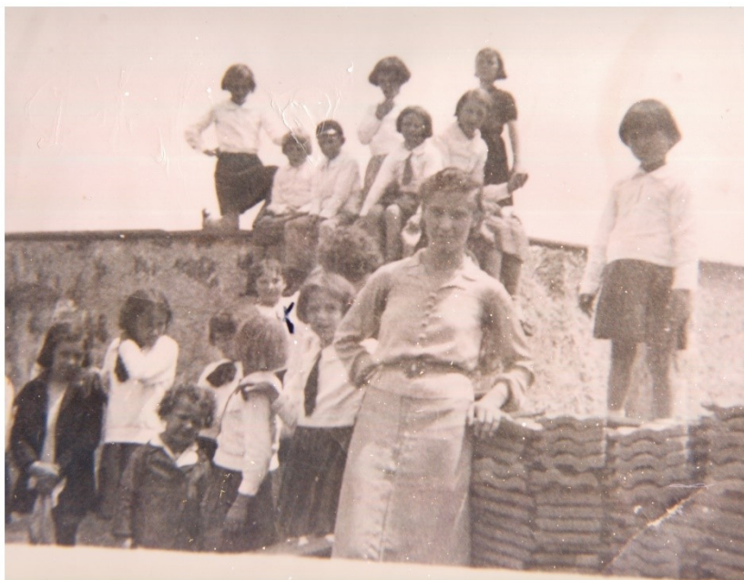
Figura 23: Início da construção do Colégio Salvatoriano Imaculada Conceição, Vila de Perdizes, 1937
