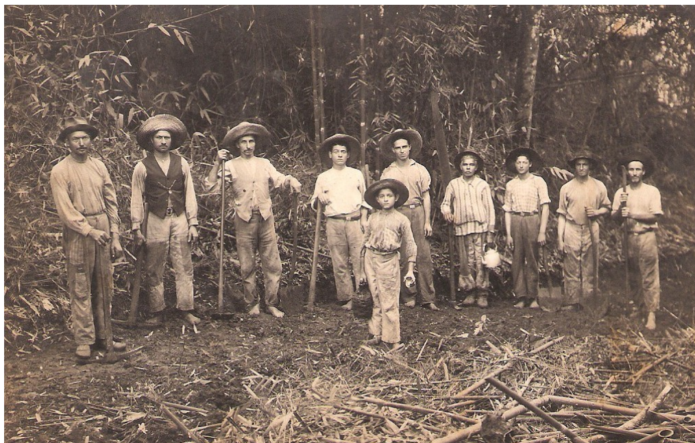
Figura 2: Colonos trabalhando na abertura da primeira estrada para a comunidade de Rio Tigre, atualmente Videira/SC 49
