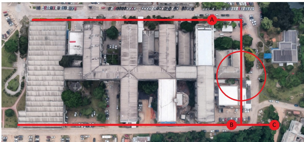
Figura 2 – Vista aérea dos Pontos de Coleta.
