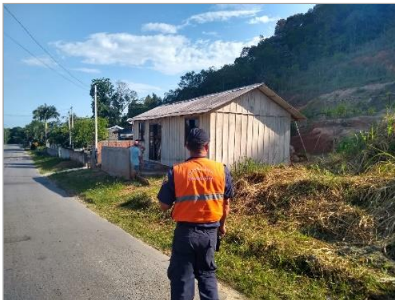
Figura 16 – Avaliação sendo efetuada por um dos técnicos de PDC em Paranaguá, PR. Destaque para os cortes efetuados ao longo do talude atrás da residência.
