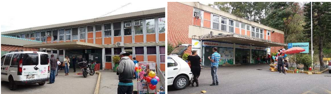
Figura 14 - Acesso ao ambulatório geral e acesso à emergência, respectivamente.
