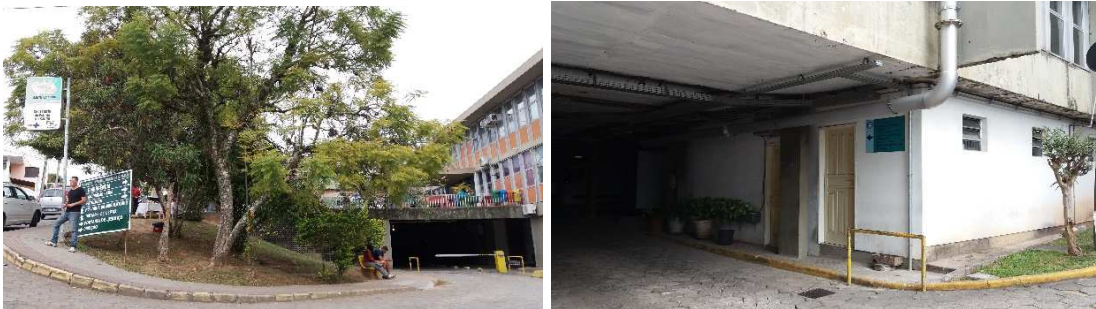
Figura 15 - Placa de identificação próxima do ambulatório e no acesso da portaria de visitas e serviços, respectivamente.
