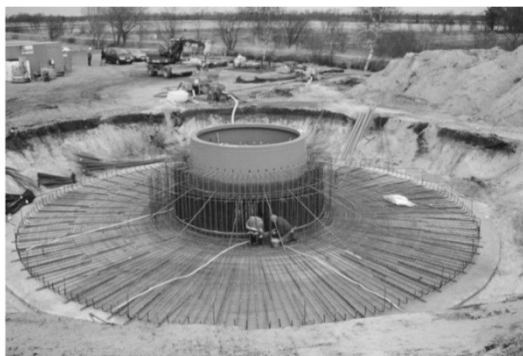
Figura 3 – Montagem do anel de aço de conexão da torre na Fundação.
