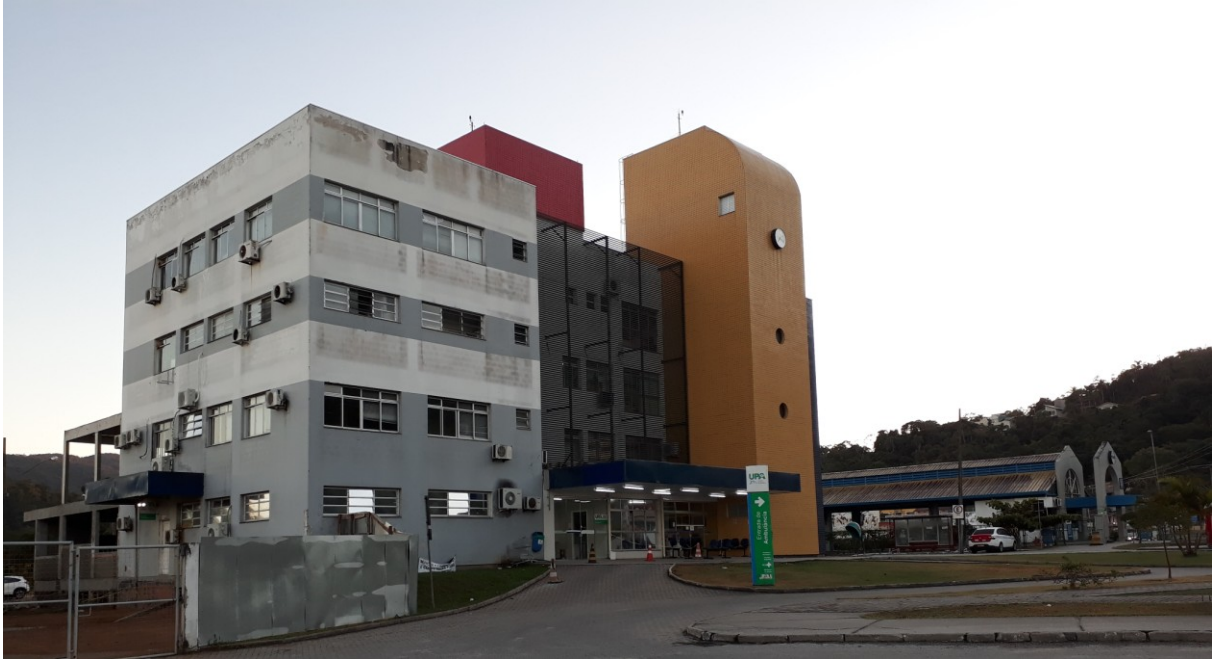
Figura 13 - Fachada da UPA-A
