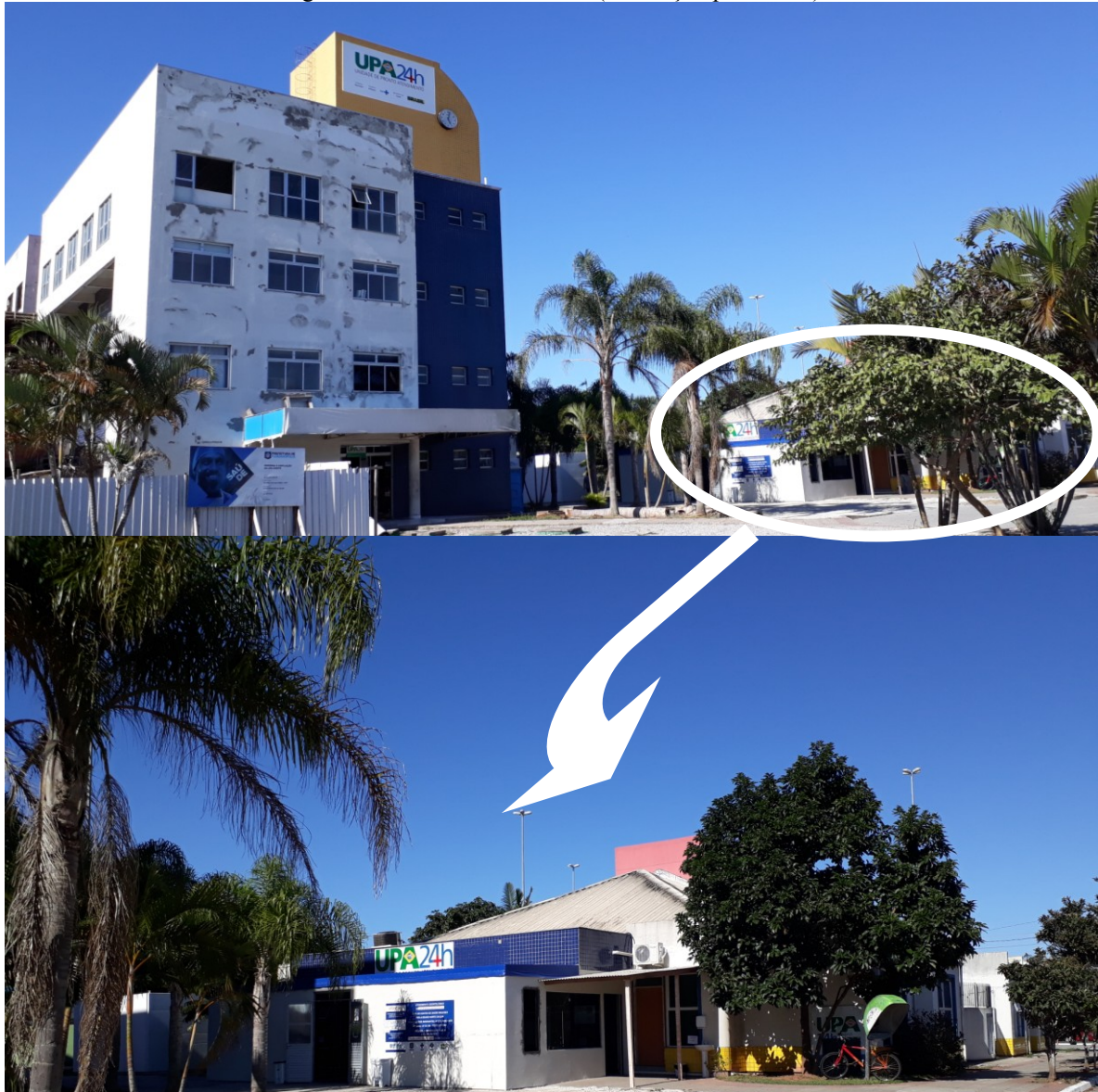
Figura 15 - Fachada da UPA-B (edificação provisória)
