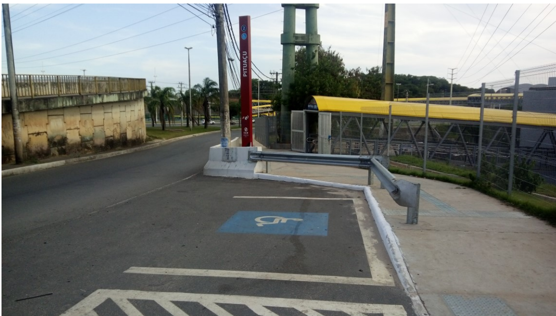
Figura 66: Acesso 01 Estação Pituacu – Avenida São Rafael
