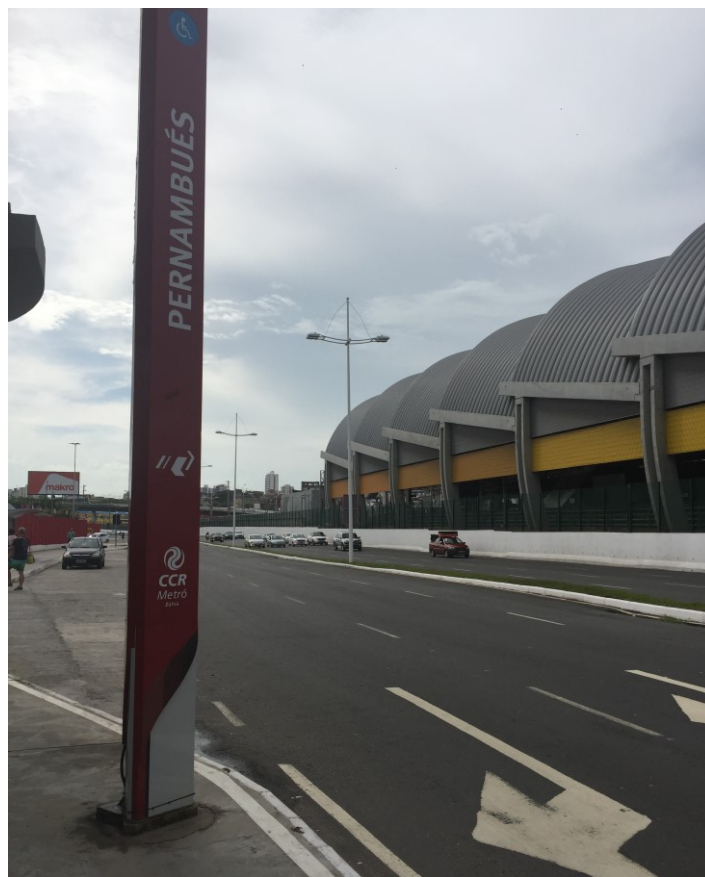
Figura 43: Vista do acesso 01 à Estação Pernambuco
