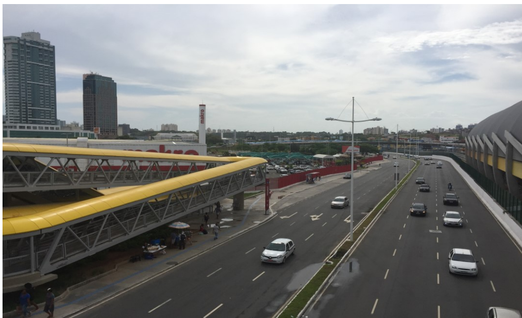
Figura 46: Vista da Avenida Tancredo Neves e Avenida Luís Viana - passarela de acesso 01 à Estação Pernambuco
