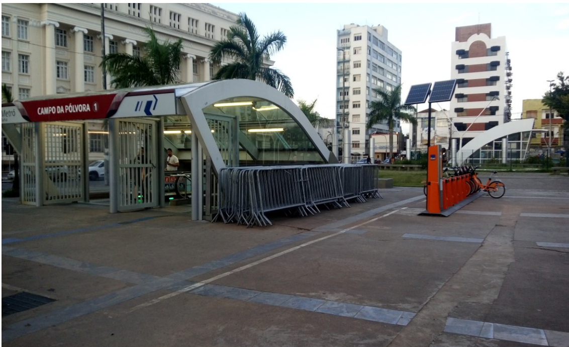
Figura 59: Acesso à Estação Campo da Pólvora
