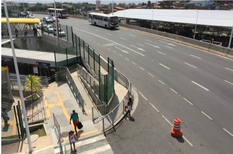
Figura 35: Vista da Avenida Santos Dumont (BA-099) e acesso à Estação Aeroporto
