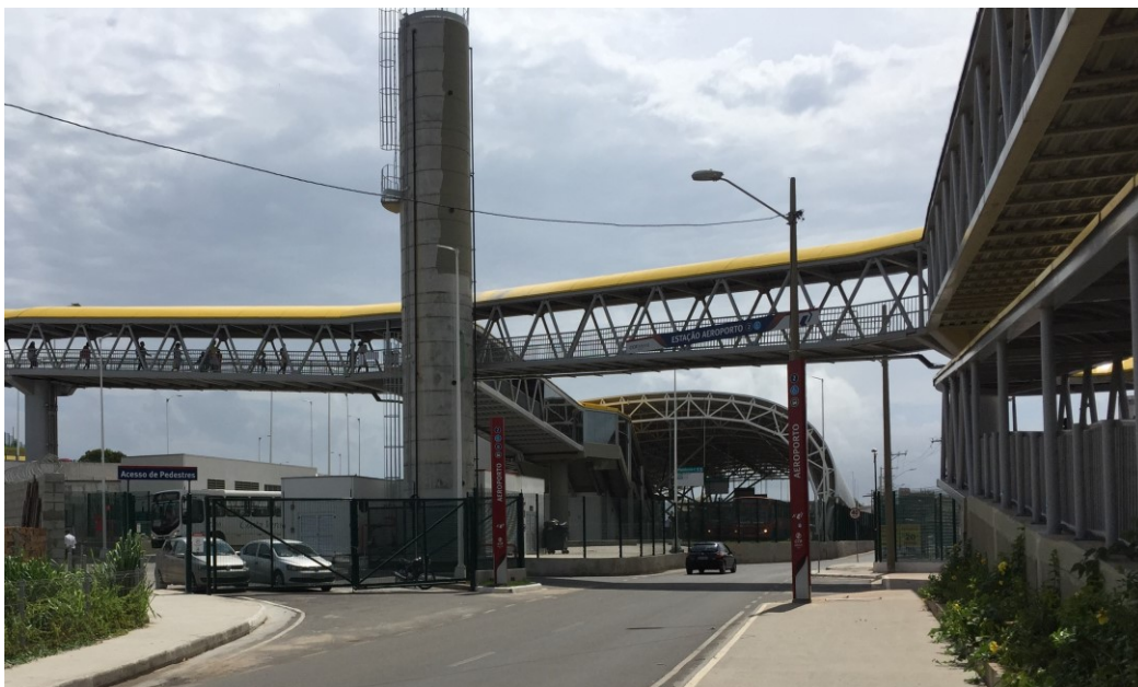
Figura 37: Acesso 02 à Estação Aeroporto
