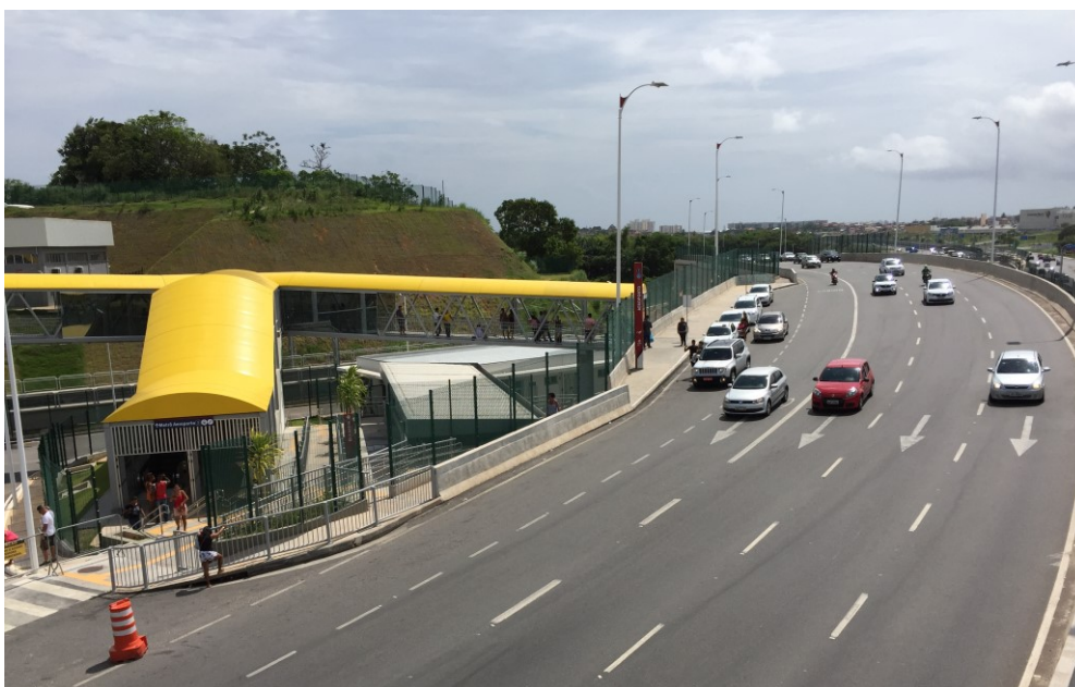
Figura 33: Vista do acesso 01 à Estação Aeroporto
