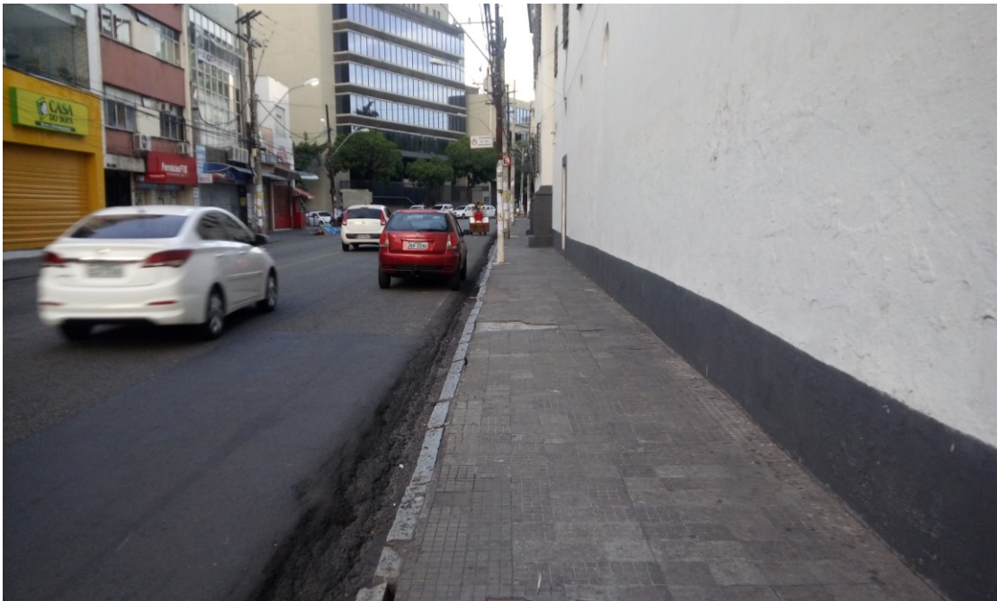
Figura 58: Avenida Joana Angélica – Via de acesso à Estação Lapa
