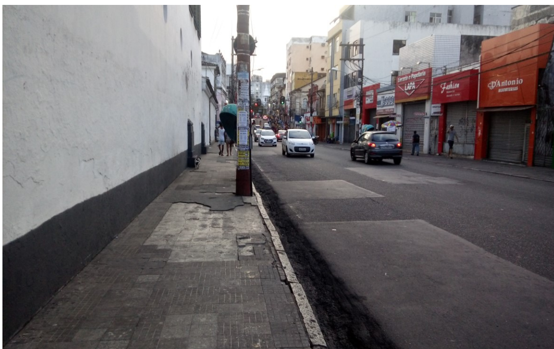
Figura 57: Avenida Joana Angélica – Via de acesso à Estação Lapa
