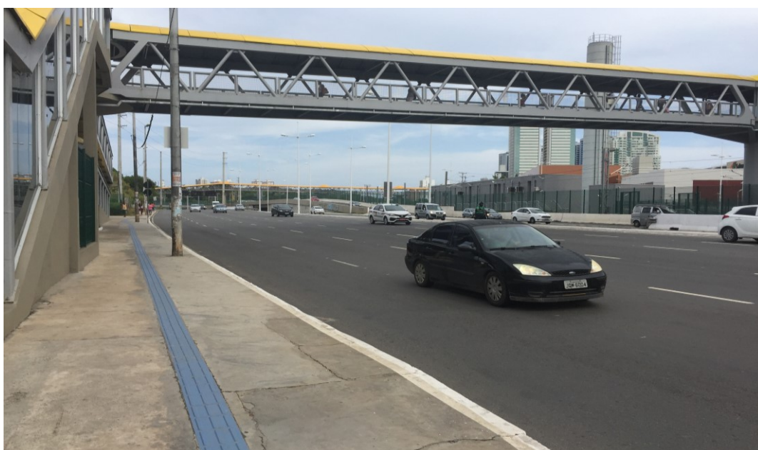
Figura 50: Vista acesso 02 à Estação Pernambuco - passarela
