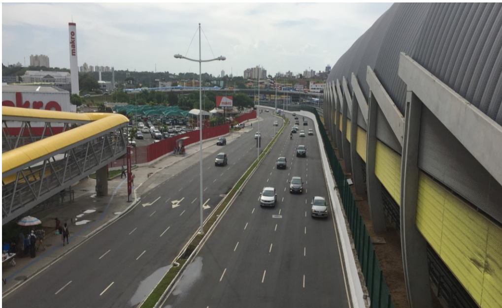
Figura 45: Vista da Avenida Tancredo Neves e Avenida Luís Viana - acesso 01 à Estação Pernambuco
