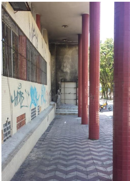
Figura 13 Marquise do Clube Doze, Avenida Hercílio Luz Fonte: Arquivos da pesquisa (fotografia da pesquisadora)
