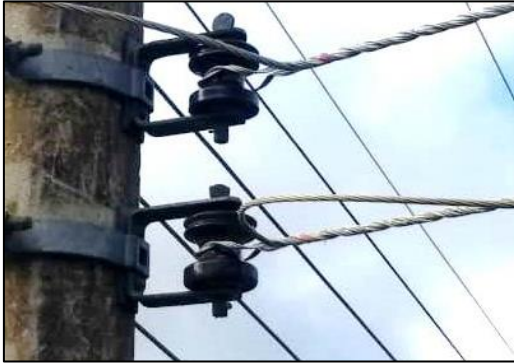
Figura 8 – Isolador tipo roldana de porcelana.
