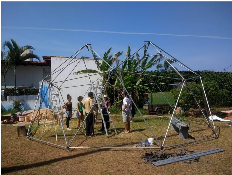
Figura 8: Montagem da geodésica de metal na Rádio Campeche (2017)
